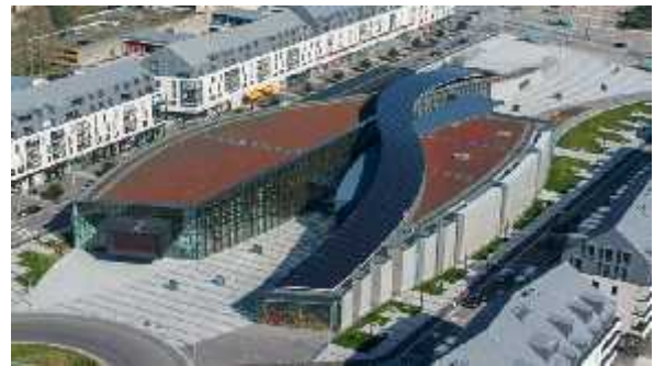
Figure I.56 : Les panneaux photovoltaïques Source : La G P P C de Saint-Malo Dossier de presse Paris, 2015
