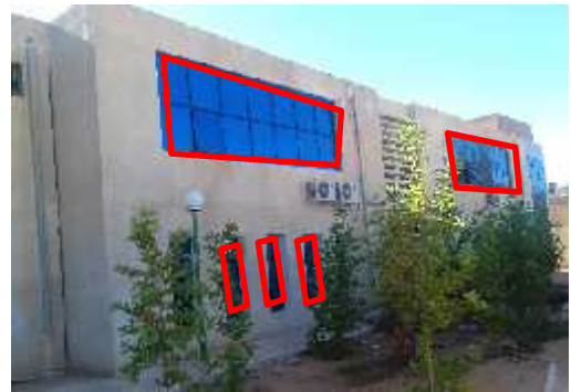
Figure I.95 : façade arrière Source : Auteur
