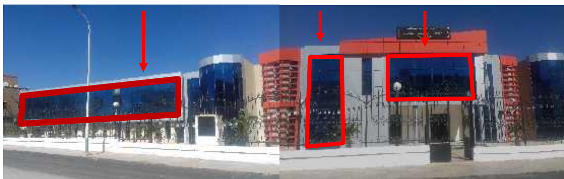
Figure I.92 : façade principale de CLS Laghouat Source : Auteur
