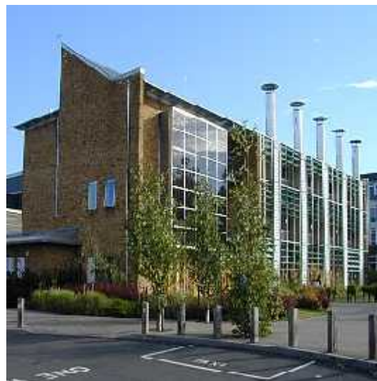
Figure I.27 : photo représente BRE. Source : Energie ploel.lesite.be
