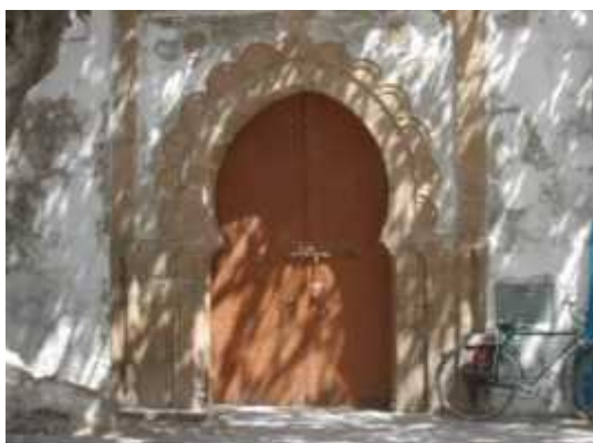
Figure II . 13 : porte d'entrée Source : auteur
