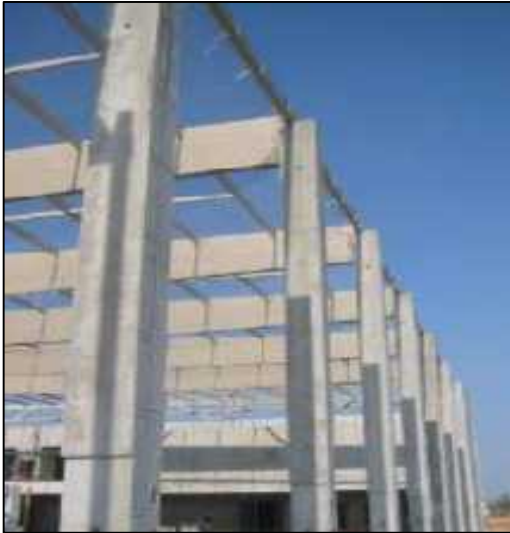
Figure V 41 : ossature en béton armé Source : http://www.calcia-infos.com
