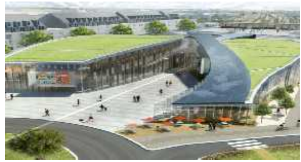
Figure I.55 : Terrasse végétalisée Source : La Grande Passerelle Pôle Culturel de Saint-Malo Dossier de presse Paris, 2015
