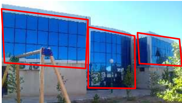
Figure I.94 : façade arrière Source : Auteur
