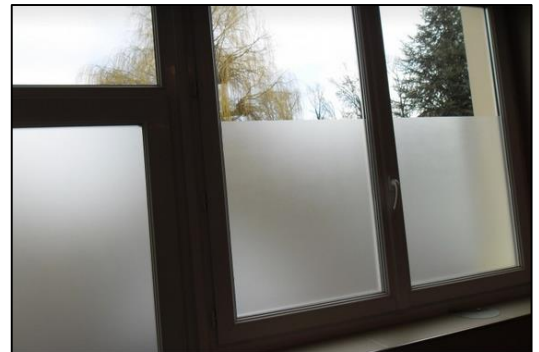
Figure 11 différence entre verre translucide et transparent Source : www.filmpourvitrage.com/films-deco-et-intimites/460-581-film-intimite-sable-mat.html
