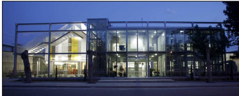
Figure 14 Façade latéral (façade légère transparente) Source : www.archdaily.com
