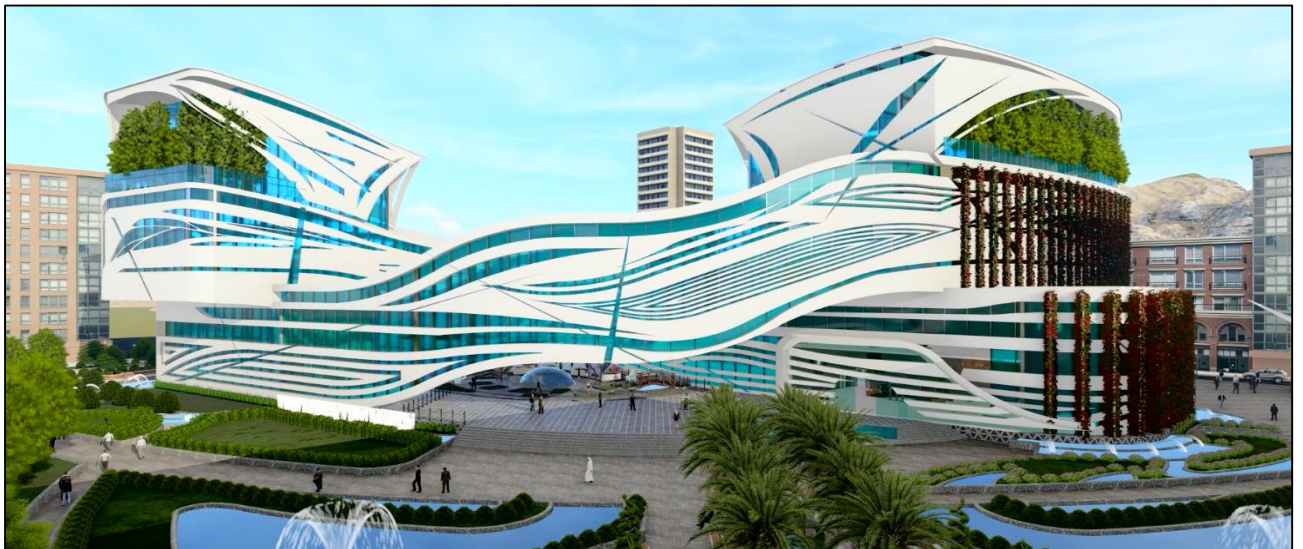
Figure 19 : Vue sur la façade nord complète
