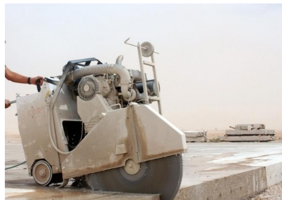
Figure 48 : Sciage de l'amorce de fissuration.
