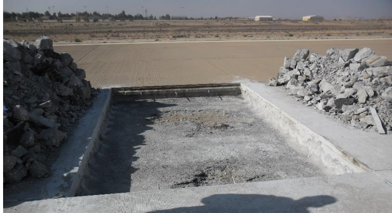
Figure 77 : Démolition d'une dalle pour réparation (piste 16L/34R).
