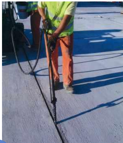
Figure 74 : Les étapes de réparation d'un joint défectueux.
