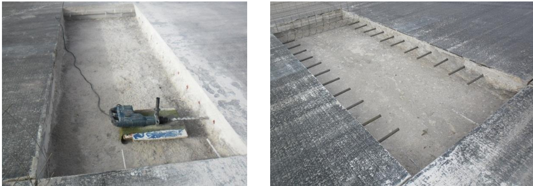
Figure 79 : Remplacement des goujons (piste 16L/34R).
