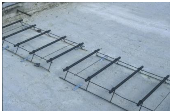
Figure 47 : Panier à goujons fixé sur la fondation.
