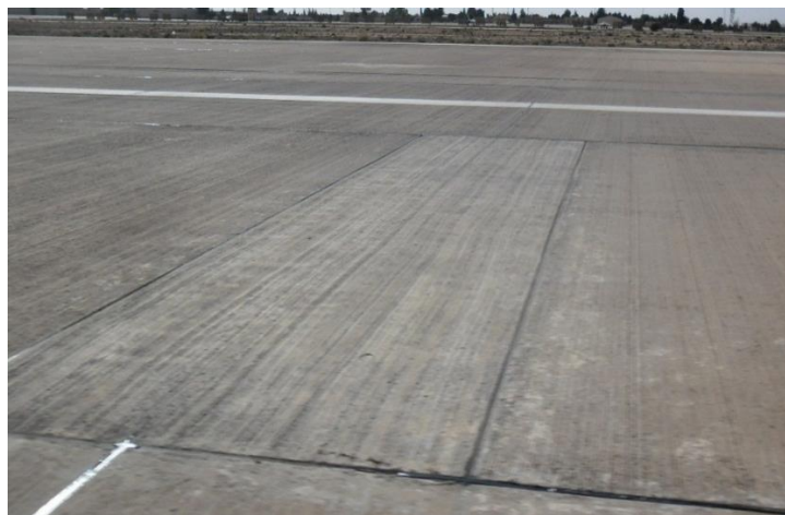
Figure 82 : Une nouvelle dalle réparée (piste 16L/34R).
