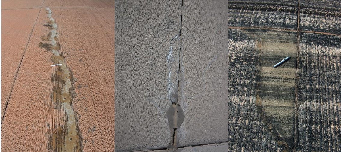
Figure 76 : Soins superficiels au niveau de la piste 16L/34R.
