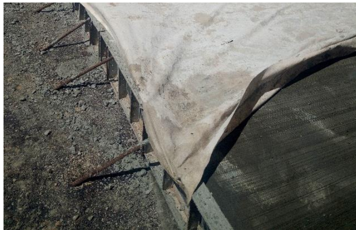
Figure 81 : Nouvelle dalle couverte par une membrane plastique.
