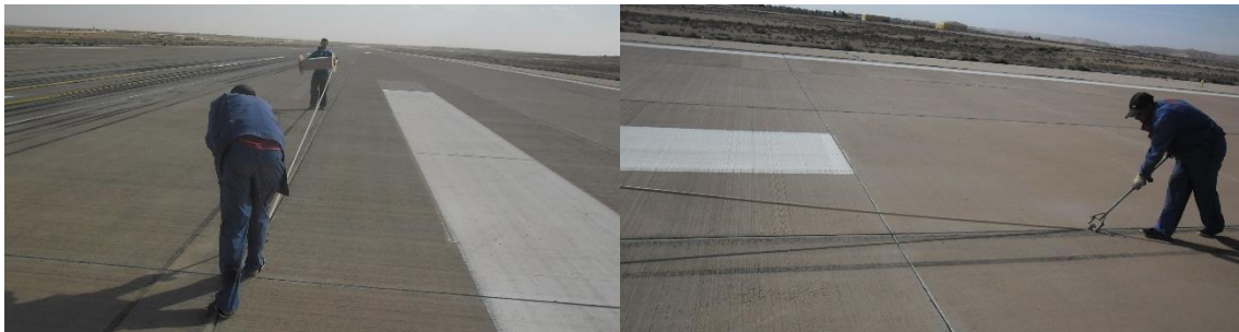
Figure 52 : Pose du fond de joint (la piste principale 16L/34R).
