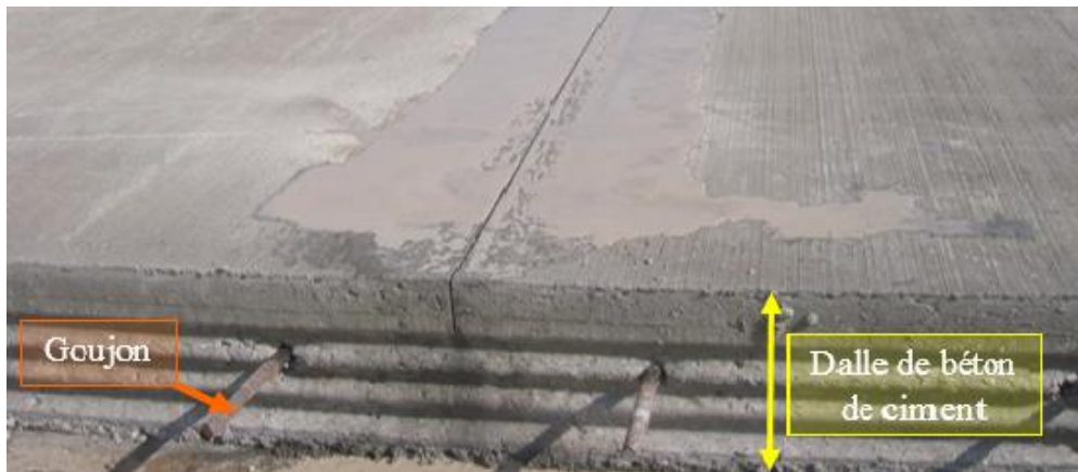
Figure 43 : Epaisseur de la dalle.
