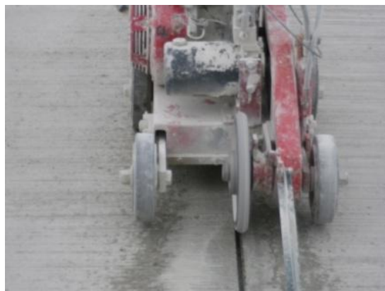
Figure 50 : Chanfreinage du logement du produit d'étanchéité.
