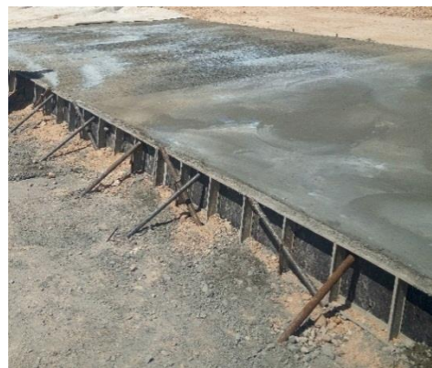
Figure 58 : Réalisation d'un joint de construction.
