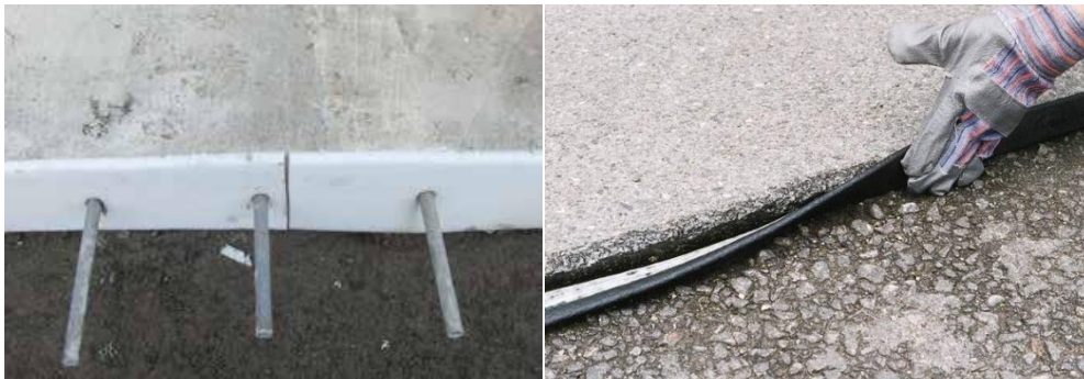
Figure 62 : Joint de dilatation transversal goujonné.
