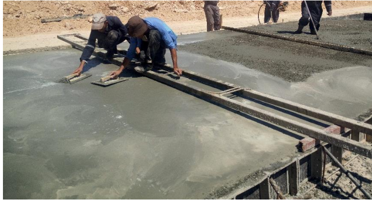
Figure 60 : Béton réalisé à la main sur la piste principale.
