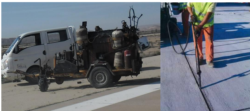
Figure 53 : Le fondeur à bain d'huile utilisé pour le garnissage des joints.
