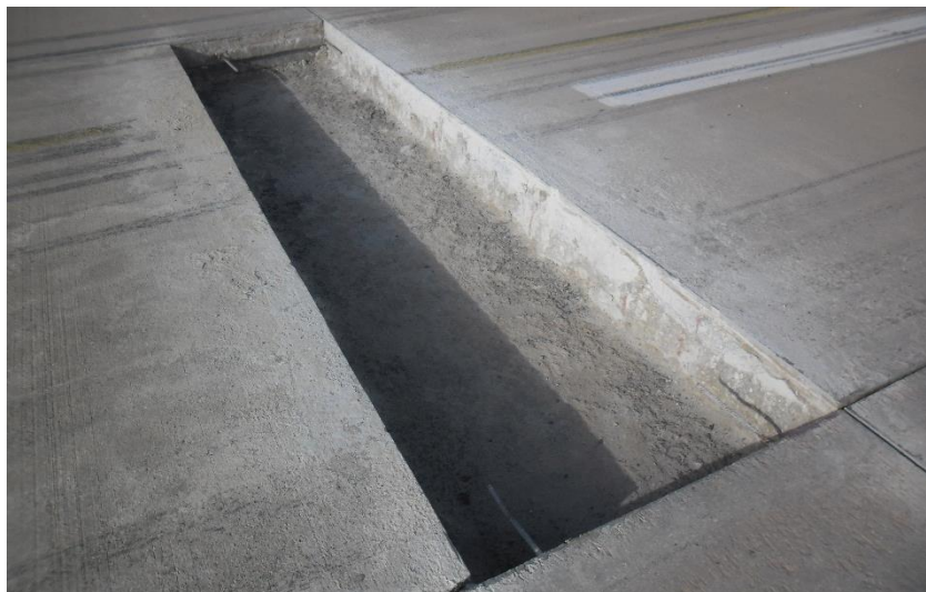
Figure 78 : Une fondation en béton maigre mise en place (piste 16L/34R).
