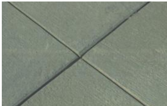
Figure 65 : Joints chanfreinés.
