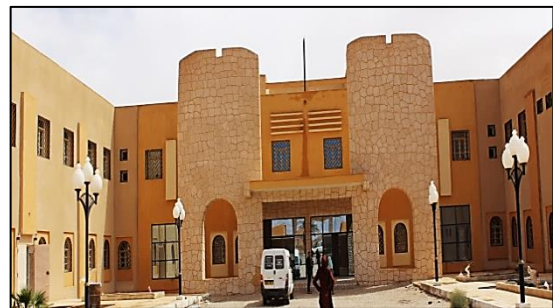
Figure 47: vue sur la façade principale de centre de psychiatrie. Source : Autour.
