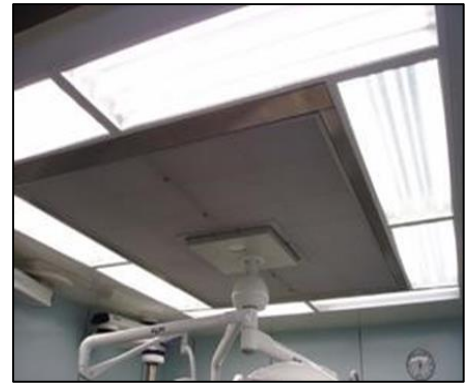
Figure 14:Exemple du faux plafond de la salle d'opération.
