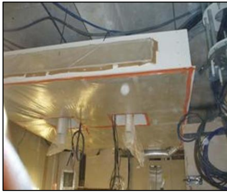
Figure 13:Faux plafond d'une salle d'opération en cours de réalisation.
