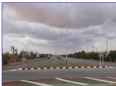
Figure 30: Vue sur la RN01.
