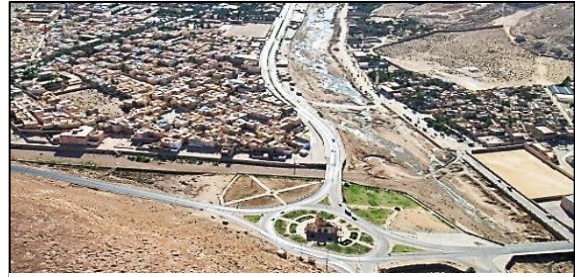
Figure 7: vue aérien de la RN01 de Ghardaïa
