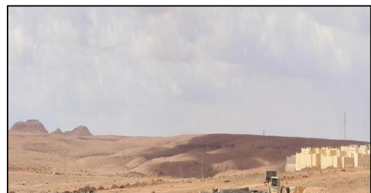
Figure 42:vue panoramique de côté ouest de site
