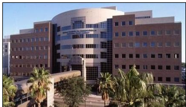
Figure 6: La façade nord de l'hôpital Shirmes. Source : Extrait de Google Earth Pro.
