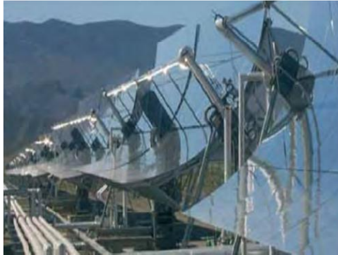
Figure 1.8 : Capteur à chaudière fixe et concentrateur mobile [3].
