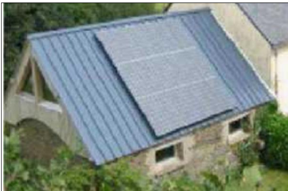
Figure 10 : Des photovoltaïques en toiture incliné
