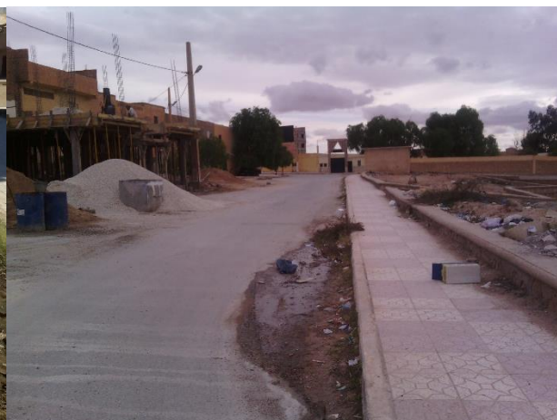
Photo 36 : Absence du système d'évacuation des eaux
