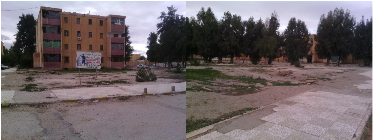
Photo 29 : Absence des espace vers
