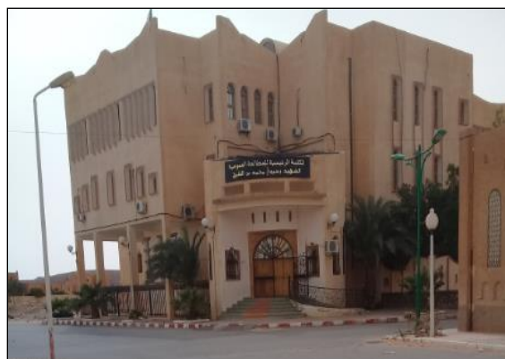
Figure 24 : vue de voie tertiaire. Source: l'auteur
