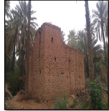
Figure 145: La maison (Dar Elghaba) Source : auteur
