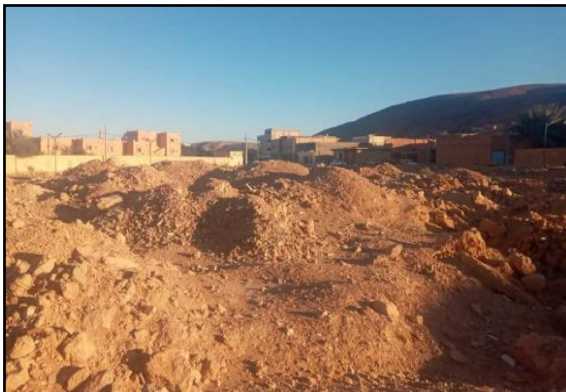
Figure 46 : L'état de lieu de site. Source: l'auteur
