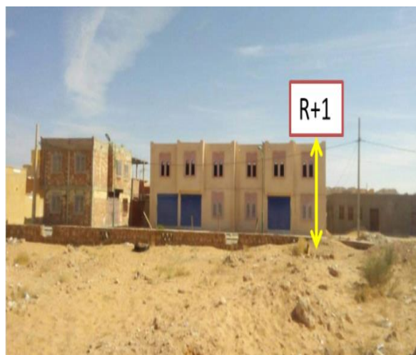
Figure 52 : Habitats semi collectif de SONEGAS. source: l'auteur.
