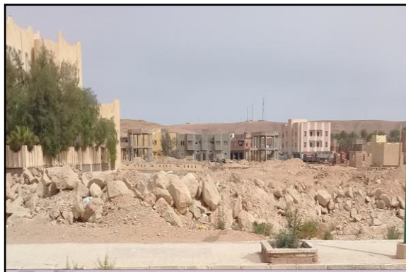
Figure 47 : L'état de lieu de site. Source : l'auteur
