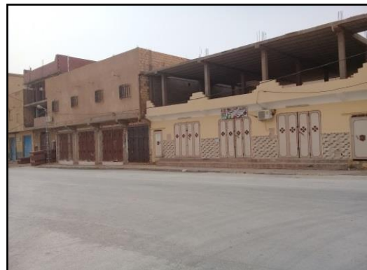
Figure 4 : vue de voie secondaire. Source: l'auteur
