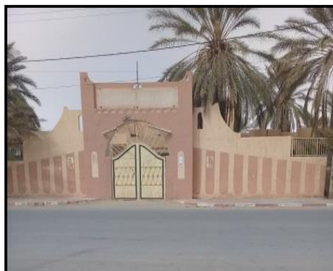
Figure 34 : lycée Ben Bitour.Source: l'auteur
