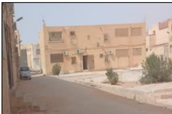
Figure 36: les logements des médecins. Source : l'auteur
