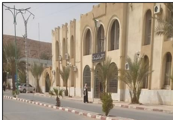
Figure 15 :vue de voie principale Source: l'auteur.
