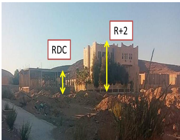
Figure 49 : Chantier de nouvelle municipale et Bibliothèque communale. Source: l'auteur
