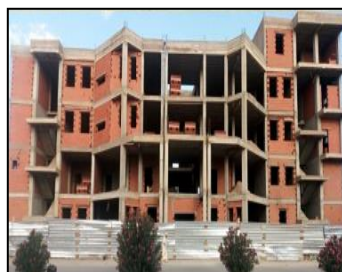
Figure 82: Chantier de nouveau CNAS R+3 et R+4 Source : l'auteur
