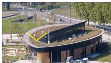
Figure105: image de toiture Source : Aquaterra Light. PDF
