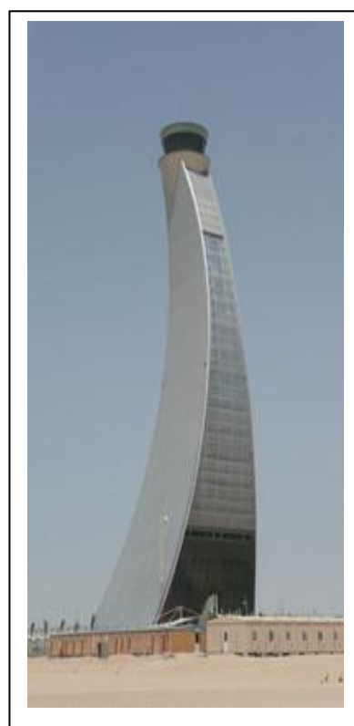
Figure III. 32: Tour de contrôle Aéroport d'Abu Dhabi 2012 [ http://www. Aiabudhabi.com ].
