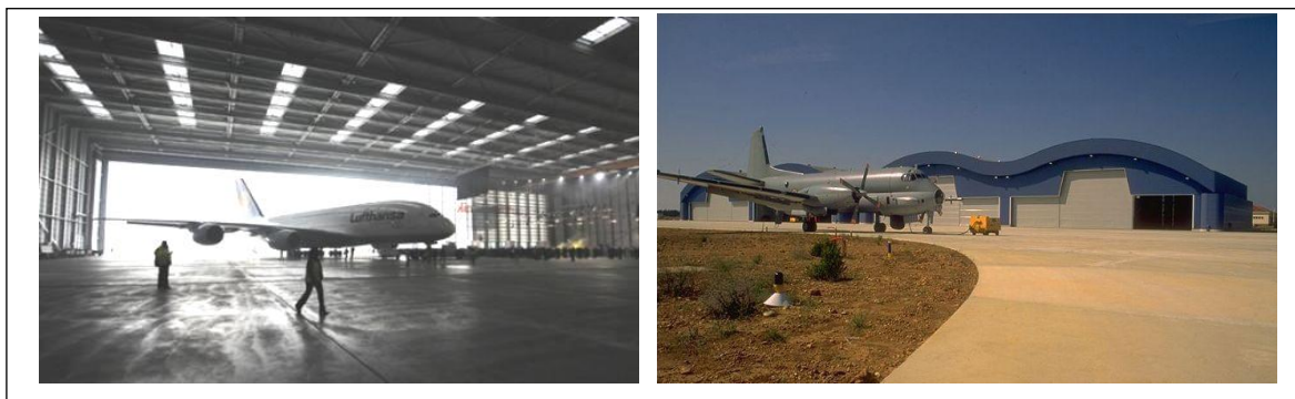
Figure III. 52: Hangars pour avions
