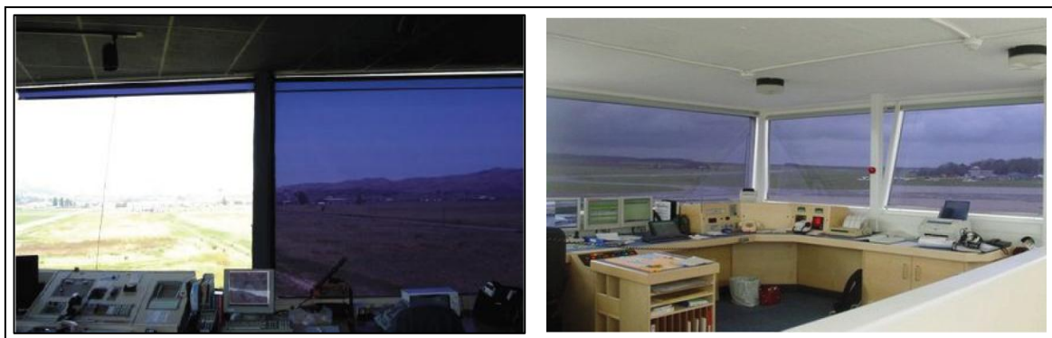
Figure V. 80 : Les écrans solaires de la tour de contrôle de l'aéroport Humberside.
