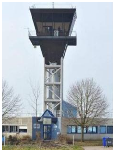
Tour de contrôle de l'aéroport de Rouen. Fût métallique.
