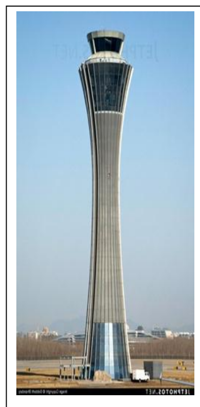
Figure III.50: Tour de contrôle Aéroport de Pékin 2012 [ http://www. Foster-partners.com ].
