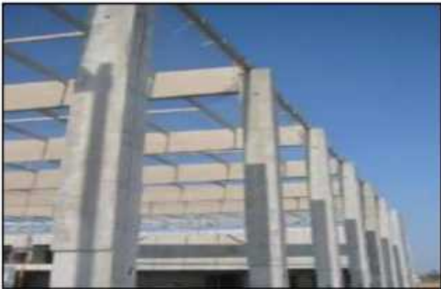
Figure 128: ossature en béton armé [Source : http://www.calcia-infos.com ]
