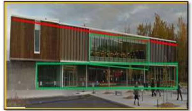
Figure15:Façade principale du bibliothèque. Lévesque. [Source : www.archdaily.com ]
