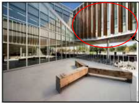
Figure 56: cour intérieur [Source : www.archdaily.com ]
