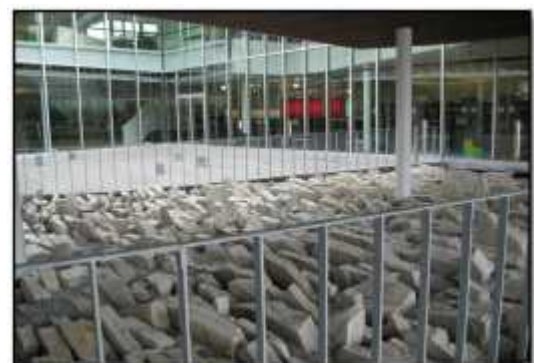
Figure 64:bassin de rétention [Source : www.archdaily.com ]
