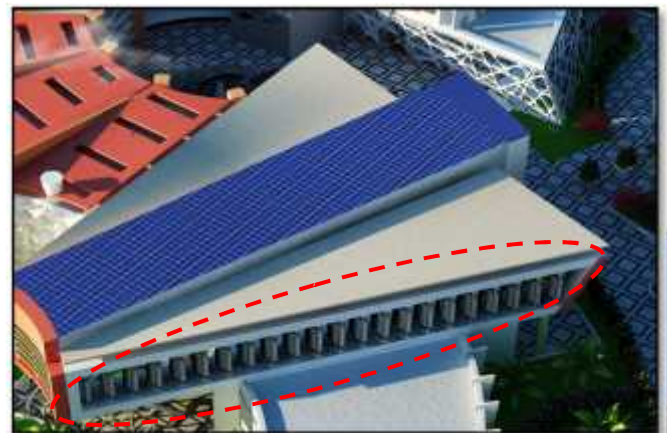
Figure 133: Façade est du bibliothèque
