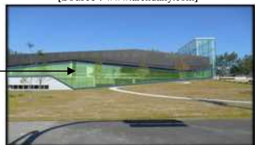
Figure 71:façade principale [Source : www.projetsverts.voirvert.ca]
