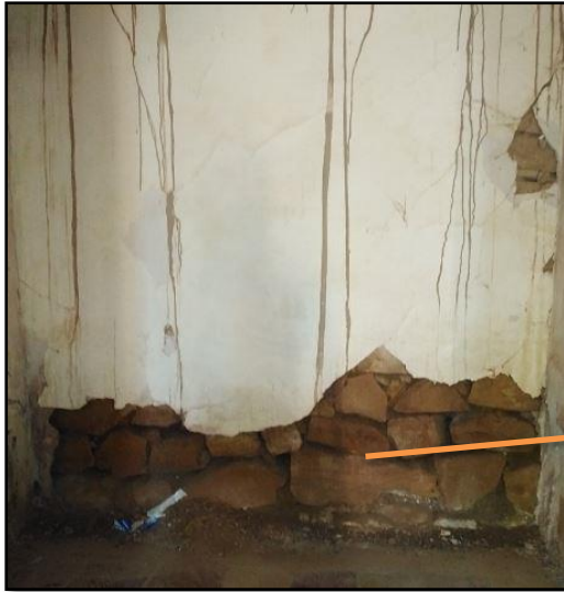
الشكل(72): مثال للأساسات لجدار من الحجارة لدار القايد المصدر: من إعداد الطالب
