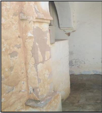
الشكل (67) : استعمال الجير في تلبيس الجدران و الأعمدة في البيت المصدر : من إعداد الطالب
