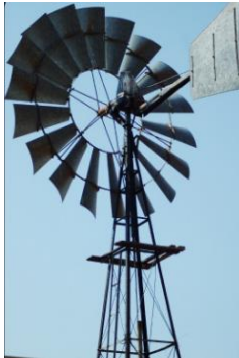
Fig. 1.13 : Moulin avec pompe à piston et à tour métallique.
