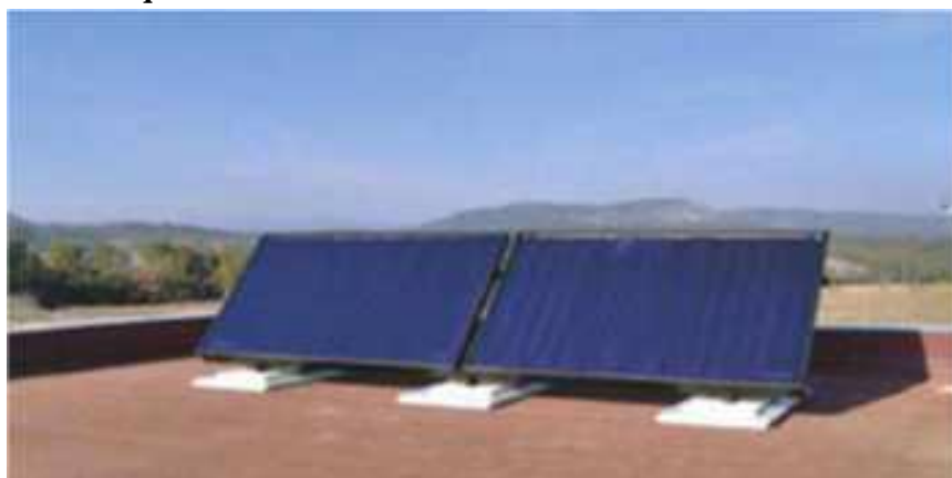
Figure 8 d'installation des panneaux photovoltaïques sur toiture terrasse
