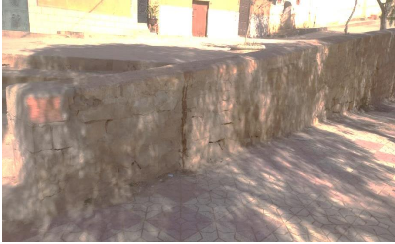
الشكل (III-27) المواد الحديثة المستعملة في ترميم نهاية الجزء (ب) المصدر : من تصوير الطالبة بتاريخ 2023/03/12
