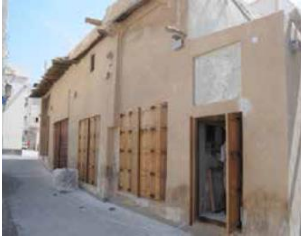
الشكل (I-12) : الواجهة الأمامية لدكاكين بعد الترميم المصدر: حفظ المباني التاريخية، إكروم – الشارقة
