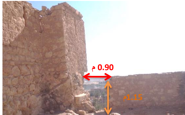
الشكل (III-26): صورة توضح الجزء المتساقط في نقطة التقاء الجزء (ب) مع البرج الشرقي (برج موراند) المصدر: من تصوير الطالبة بتاريخ 2023/03/12
