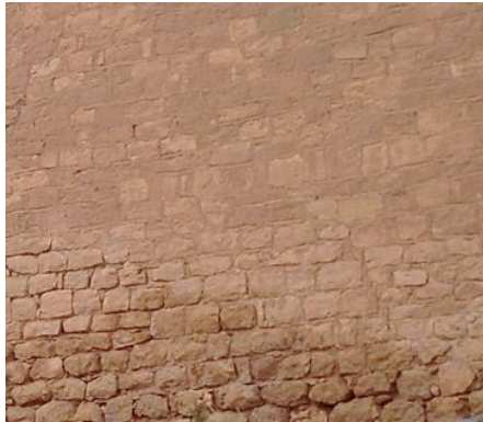
الشكل(III-05): البناء بحجاره الدبش في الجزء(هـ) المصدر: من تصوير الطالبة بتاريخ 2023/02/16
