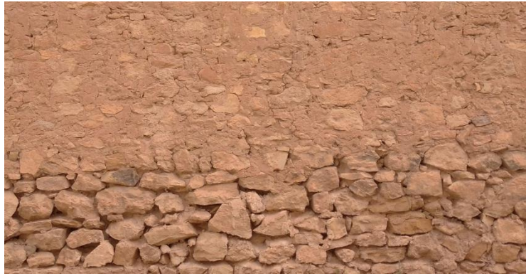
الشكل(III-05): البناء بحجاره الدبش في الجزء(هـ) المصدر: من تصوير الطالبة بتاريخ 2023/02/16
