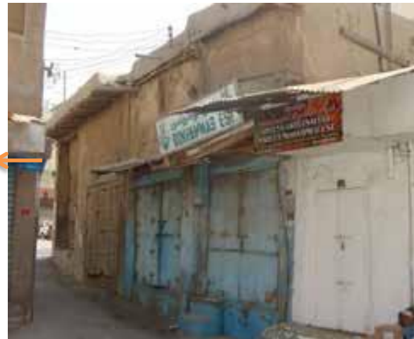
الشكل (I-11) : الواجهة الأمامية لدكاكين قبل الترميم المصدر: حفظ المباني التاريخية، إكروم – الشارقة
