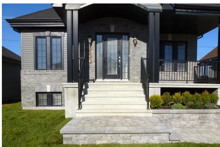
Figure IV.1 : porte d'entrée principale. Source : www.maison-deco.com
