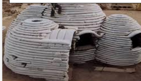
Figure I.44 la mise en œuvre de l'éco dom. Source : www.ecolopop.info/
