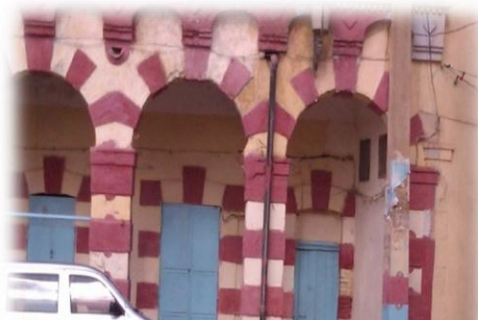
Figure II.20 : Les arcades dans les façades. Source : Auteur.
