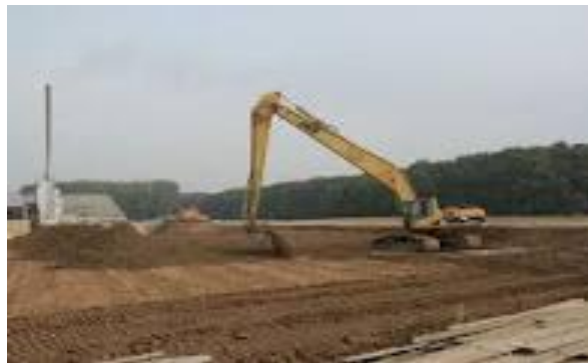
Photo I.6: Type de barrière étanche (Couches d'argile).
