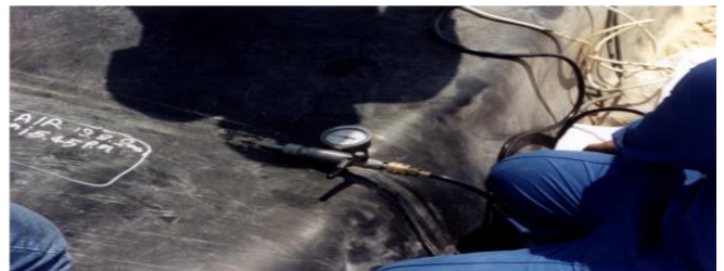
Photo I.9 : contrôle systématique des soudures
