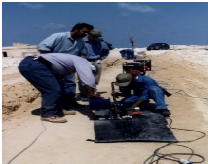
Photo I.9 : contrôle systématique des soudures
