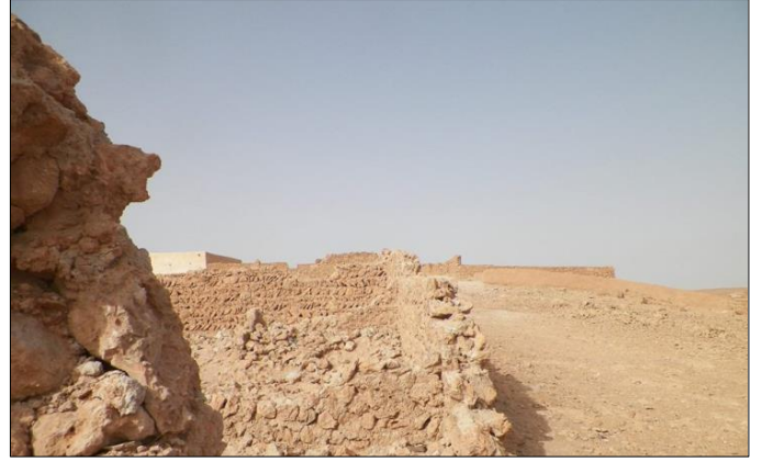
صورة 39 أجزاء من المساكن منهارة في القصر المصدر : الباحث بتاريخ 2022-02-19
