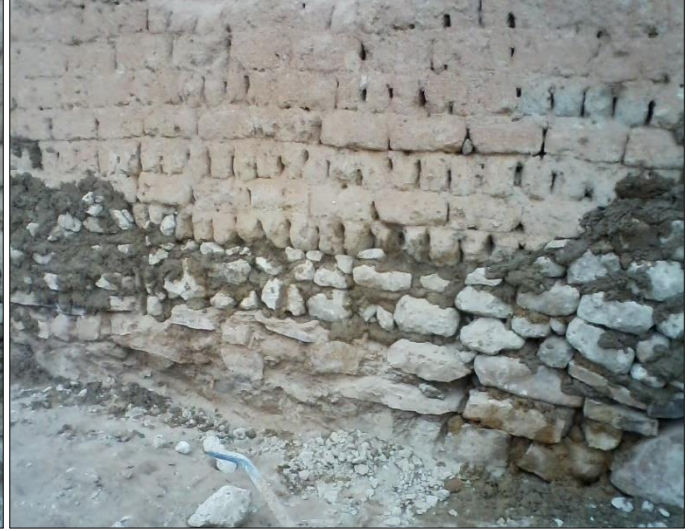
صورة 21 توضح اشغال الترميم في قصر تاجرونة
