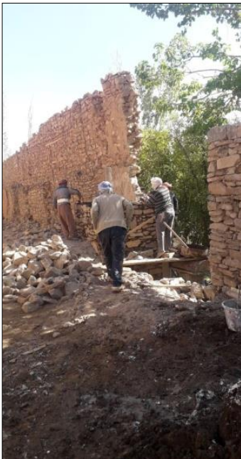
صورة 13 اثناء عملية البناء لمصدر : مكتب دراسات جسور
