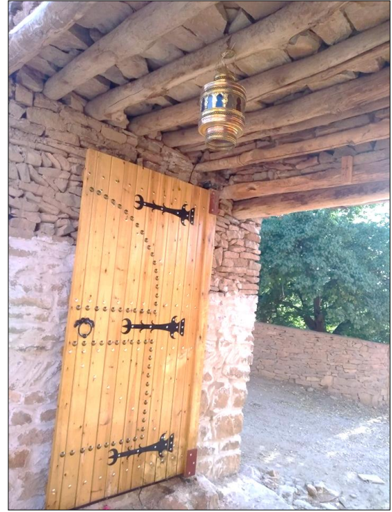
صورة 14 توضح الأبواب بعد الترميم المصدر : مكتب الدراسات جيسور
