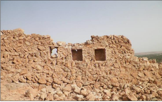
صورة 38 أجزاء من المساكن منهارة في القصر المصدر : الباحث بتاريخ 2022-02-19
