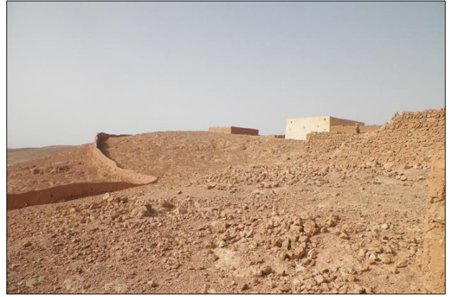
صورة 37 أجزاء من المساكن منهارة في القصر المصدر : الباحث بتاريخ 2022-02-19
