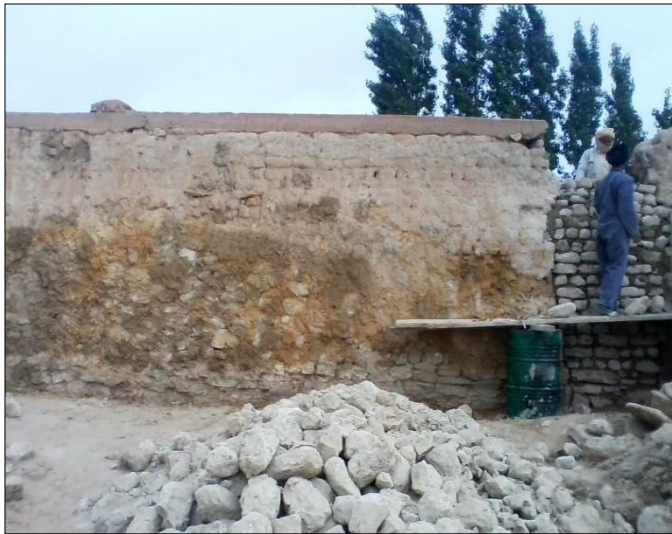
صورة 23 تبين اشغال البناء المصدر : مكتب الدراسات جسور
