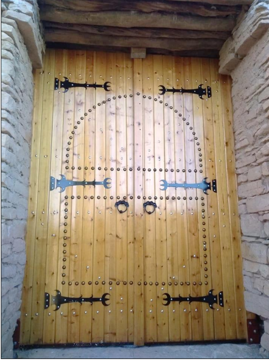
صورة 15 توضح الأبواب بعد الترميم المصدر : مكتب الدراسات جيسور
