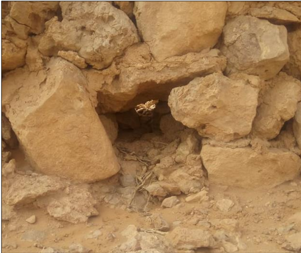
صورة 49 تبين فتحات تصريف الامطار (تعمل بشكل عادي) المصدر : الباحث بتاريخ 2022-02-19
