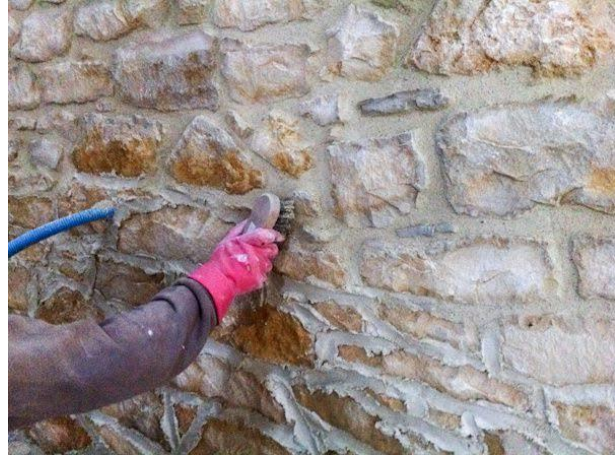
صورة 01 توضح التنظيف بخرطوم الهواء والفرشاة للفواصل لمصدر : الانترنت
