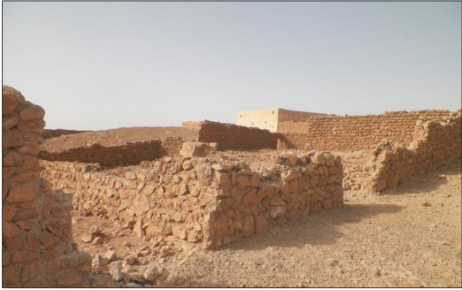
صورة 40 أجزاء من المساكن منهارة في القصر المصدر : الباحث بتاريخ 2022-02-19
