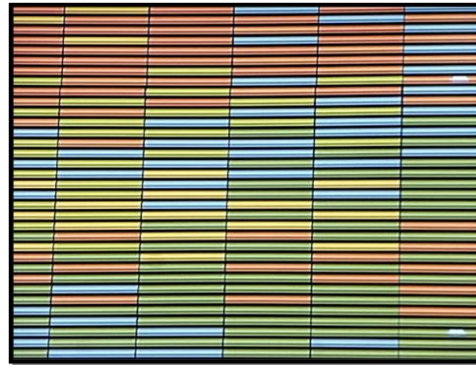
Figure 0-38: Pose des Brises solaires colorés sur l'ossature
