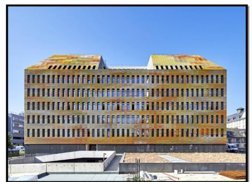
Figure 0-17: Centre de recherche en biomédecine de Strasbourg (Source : http://groupe-6.com/projet/architecture-recherche-medicale-crbs/ )
