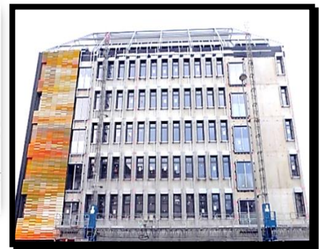
Figure 0-35: Façade sud du Centre de recherche en biomédecine de Strasbourg
