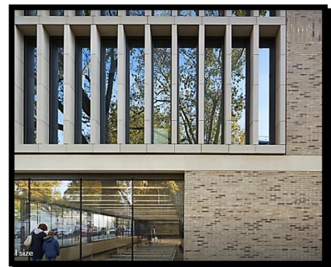
Figure 0-91: Revêtement des murs extérieurs en terre cuite
