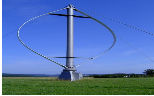
Fig. I.3 : Éolienne de type Darrieus.
