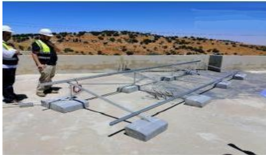
Figure IV.2 : La structure est en aluminium ou en alliage d'aluminium.
