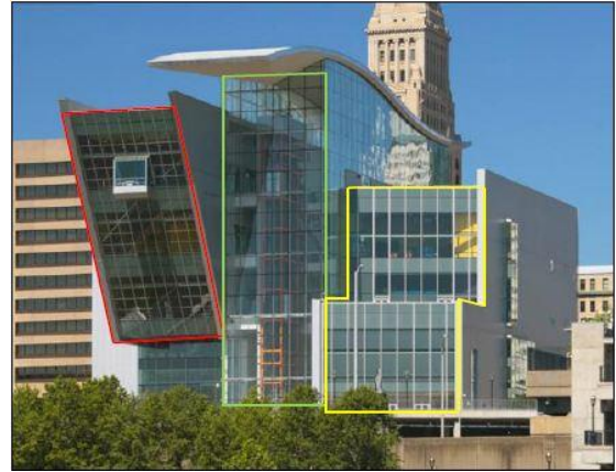
Figure 13 : photo de la façade Est
