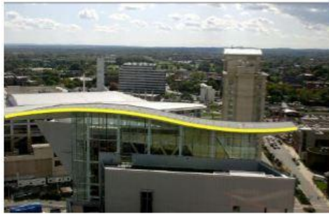
vue du toit en forme de S
