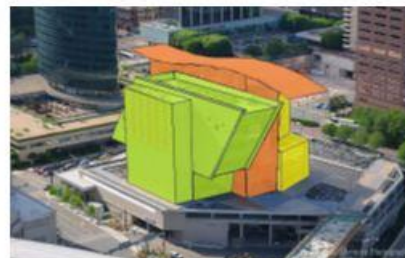
vue du côté Sud est du bâtiment présente les 03 blocs
