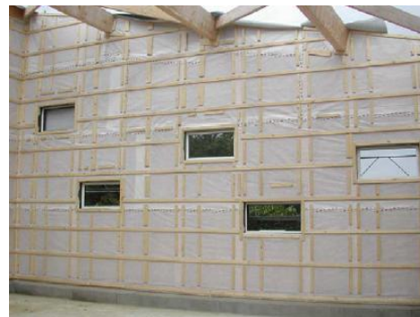
Figure 18 : Vue intérieur de la structure en bois
