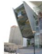
Entrée secondaire au niveau du bloc orienté Sud
