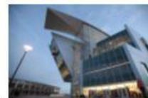
Entrée secondaire au niveau du bloc orienté Nord
