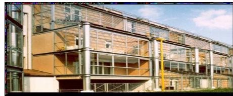
Figure 23 : Protection Solaire par les espaces tampon Source : www-energie2.arch.ucl.ac.be
