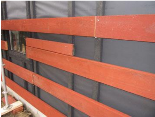
Figure 13 : photo de la façade en cour de réalisation
