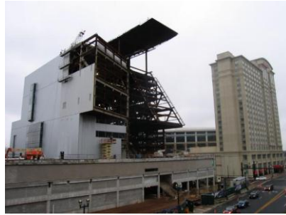
Figure 16 : vue du projet en cours d'exécution
