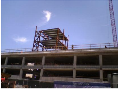
Figure 15 : vue du parking public en cours d'exécution
