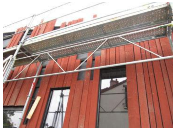
Figure 14 : photo de la façade en cour de réalisation
