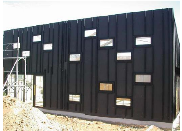
Figure 20 : Le pare-pluie noir posé à l'extérieur
