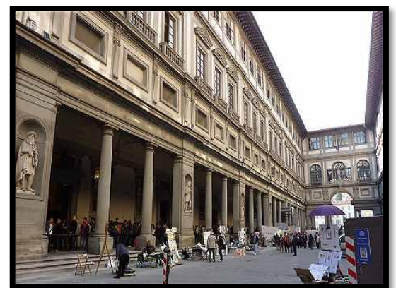
Figure I-3/musée public à Florence destiné à accueillir des bureaux administratifs. Source : internet.
