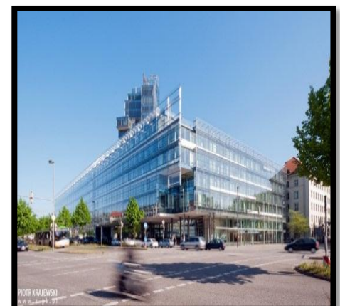
Figure I.18 : La double peau de Norddeutsche Landesbank. Source: internet
