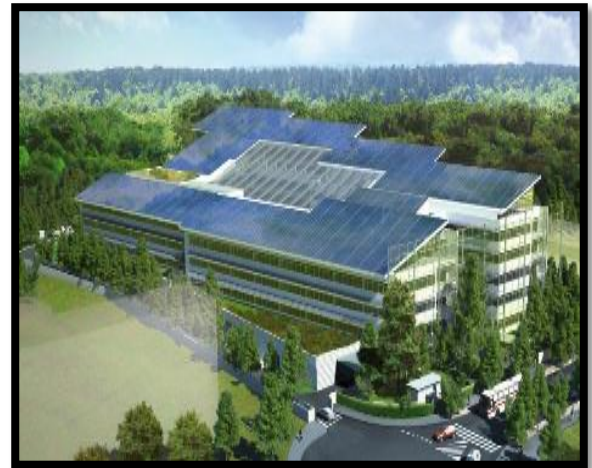
Figure I. 46 : photo de la toiture du projet. Source : internet
