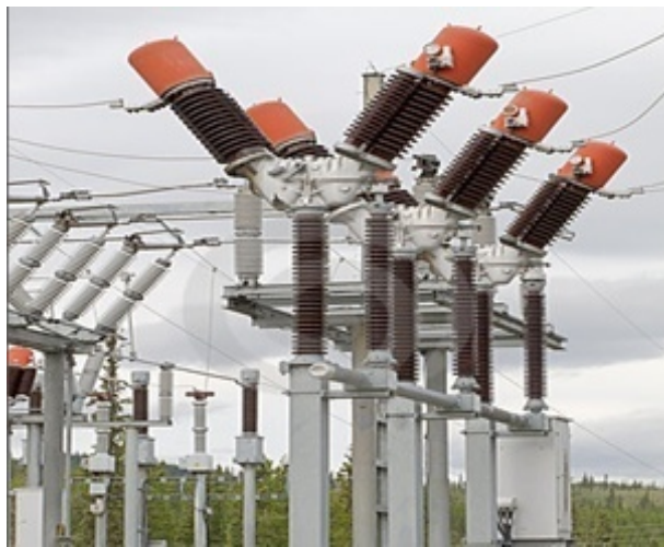
Fig.1.10 Disjoncteur à air comprimé [10]
