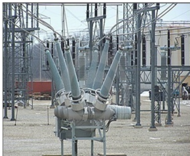
Fig.1.11 Disjoncteur au SF 6 [11]
