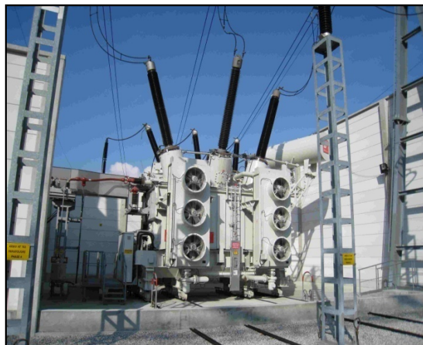
Fig.1.6 Transformateur Haute tension Nouvelle Génération 600 MVA 385 kV [6]
