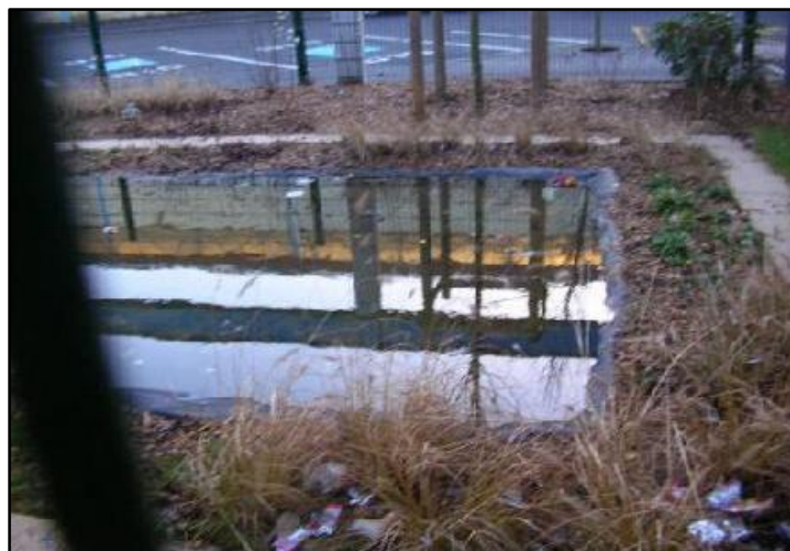
Figure I. 19 : Un bassin de rétention des eaux pluviales
