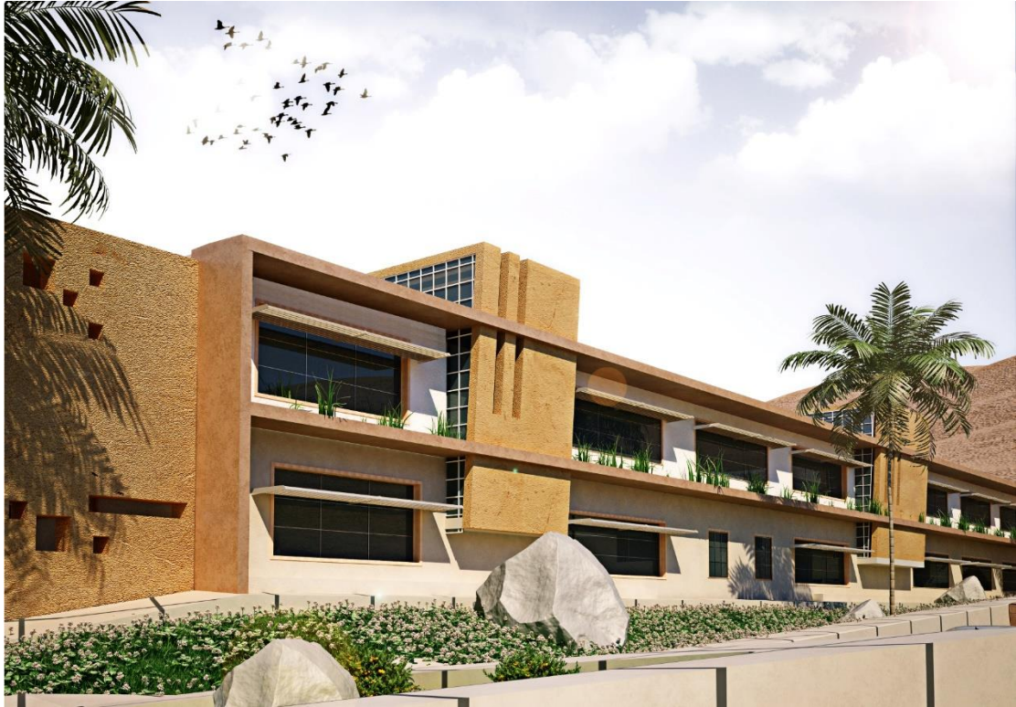
Figure X. 31 : Vue sur la façade Sud (Source : Auteurs).
