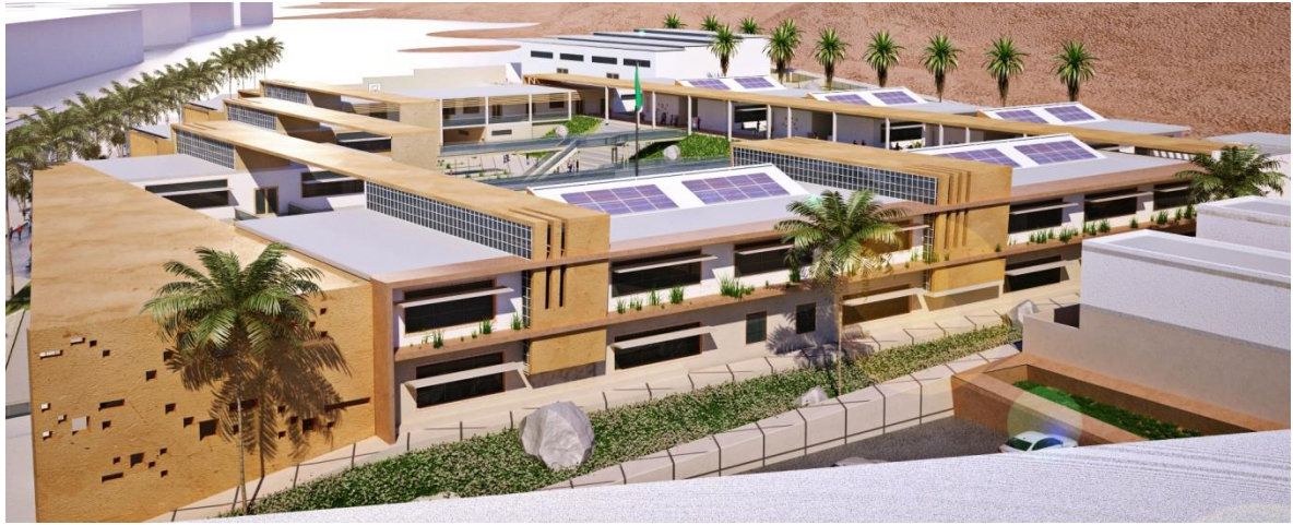
Figure X. 35 : Vue générale sur le projet (Source : Auteurs).
