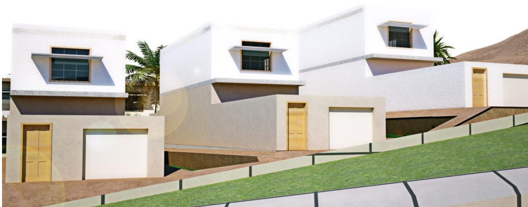
Figure X. 45 : Les logements de fonction
