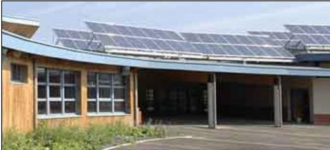
Figure I. 21 : Les panneaux solaires
