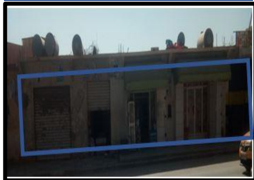
وظيفة تجارية، المبنى قديم وواجهة غير مكتملة
