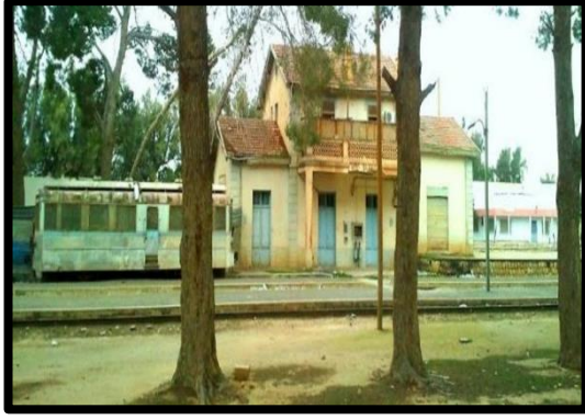
صورة 68 توضح لمحطة القطار
