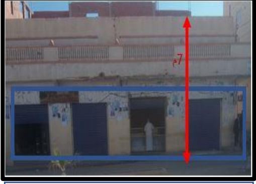
وظيفة تجارية وسكنية، ارتفاع المباني يصل الى 7م، المبنى قديم وواجهة غير مكتملة
