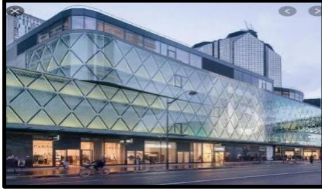
صورة 41 توضح الواجهة الجانبية للمركز تجاري
