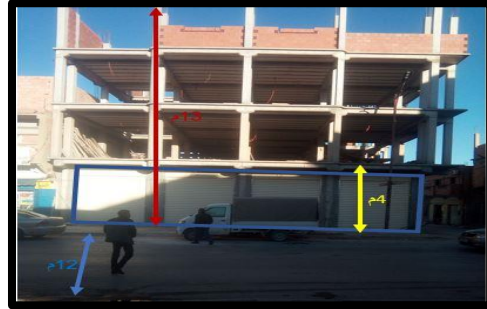
مبنى جديد الانشاء، يوضح ان الوظيفة تجارية سكنية وارتفاع المبنى 13م، عرض الطريق 12م
