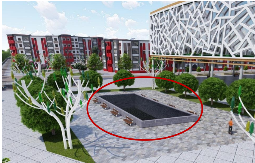
الشكل 3-18 : صورة توضح فتحات التهوية الخاصة بموقف السيارات تحت الارض. المصدر : الطلبة.
