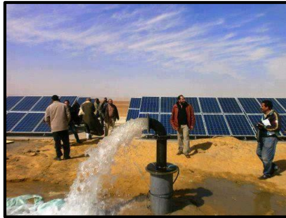
الشكل 4-14: صورة توضح تموضع الخلايا الشمسية التي تساهم في رفع المياه.
