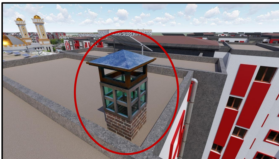
الشكل 4-39: صورة توضح الملفف الذي يعمل بتقنية الاحتباس الحراري. المصدر: الطلبة.
