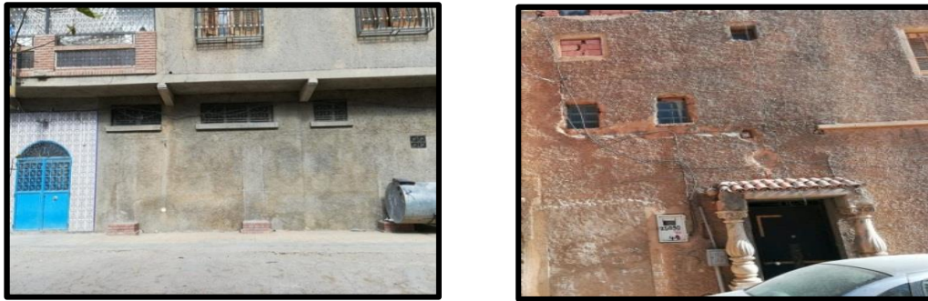
الشكل 2-8-9 : صورة تبين مختلف مواد البناء المستعملة في مسكن خاص. المصدر: الطلبة.
