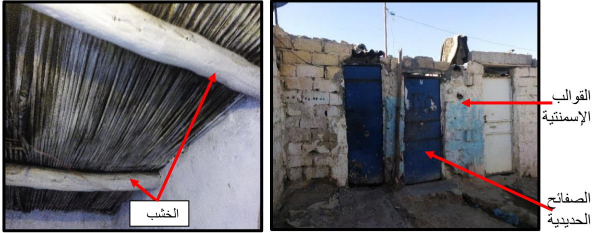
الشكل 29-30 : صورة تبين مواد البناء المستعملة داخل و خارج المسكن القصديري. المصدر : الطلبة.
