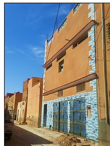
Fig.II.27 : maison traditionnelle transformé dans l'ancien quartier (extension vertical, garage, nouvelle façade) (source : bureau d'études)
