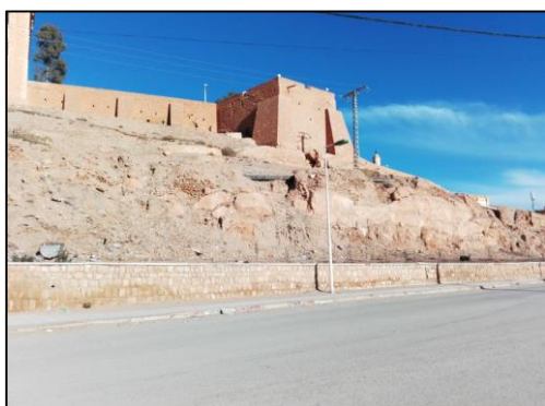
FigIII.16 : vue sur la partie de terrain T1 de la zone A (source auteurs)
