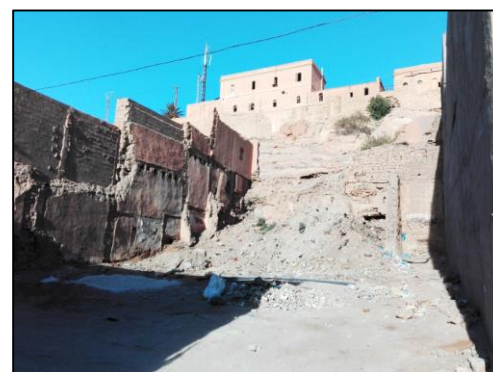
FigIII.17 : vue sur la partie de terrain T2 de la zone A (source auteurs)
