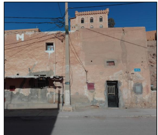
FigIII.9 : maison à réhabilité (source auteurs)
