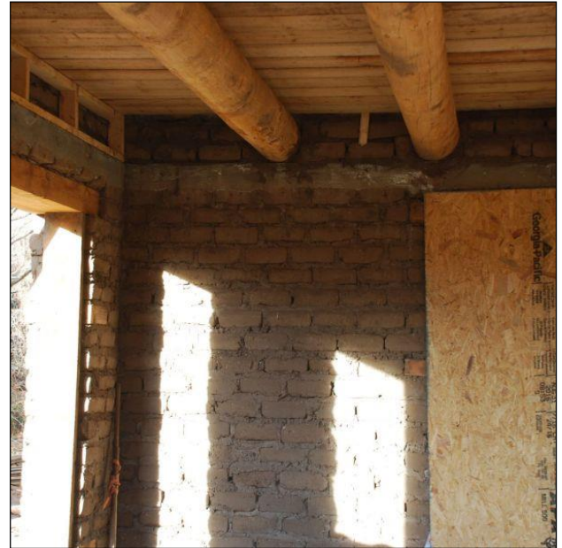
Fig I. 44 : une maison lors de la construction, (source : www.cap-a.fr/construction-terre-crue-nouveau-mexique )
