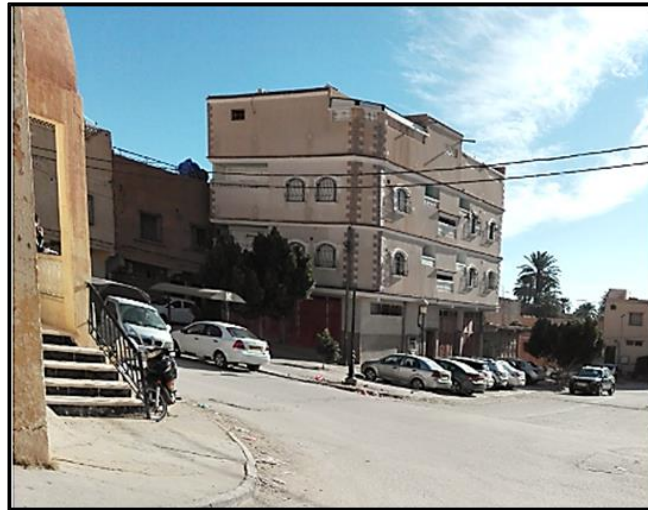
Fig.II.26 : les stationnements automobiles et l'extension d'une construction au milieu de rahbat Sidi Chikh de l'ancien quartier de Laghouat. (Source : les auteurs)
