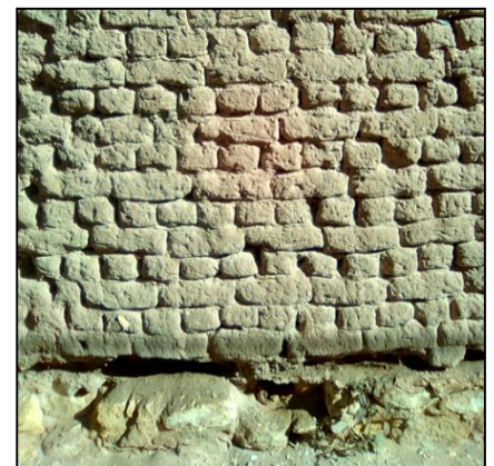
FigI.16 : l'appareillage d'un mur en adobe (source : auteur).
