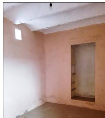
Fig II.23 : planché en voutain (source : auteurs)
