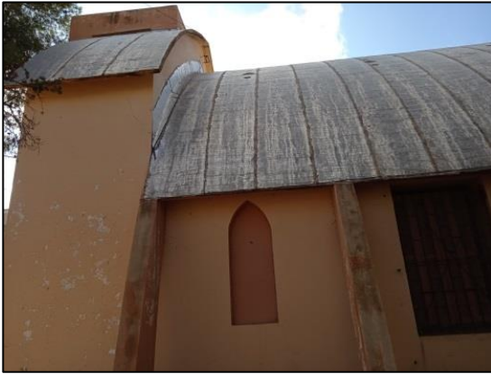
الشكل 42: السقف بالخرسانة المسلحة المصدر: الطالبة
