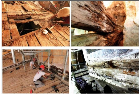
الشكل 37: جزء من الدعائم والغطاء الخشبي الذي تآكل أثناء الترميم المصدر: https://ar.wikipedia.org
