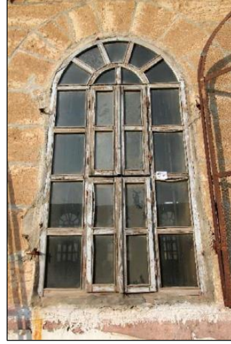
الشكل 45: الشباك قبل الترميم المصدر: https://ar.wikipedia.org
