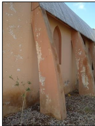
الشكل 32-33: دعائم السقف المصدر: الطالبة
