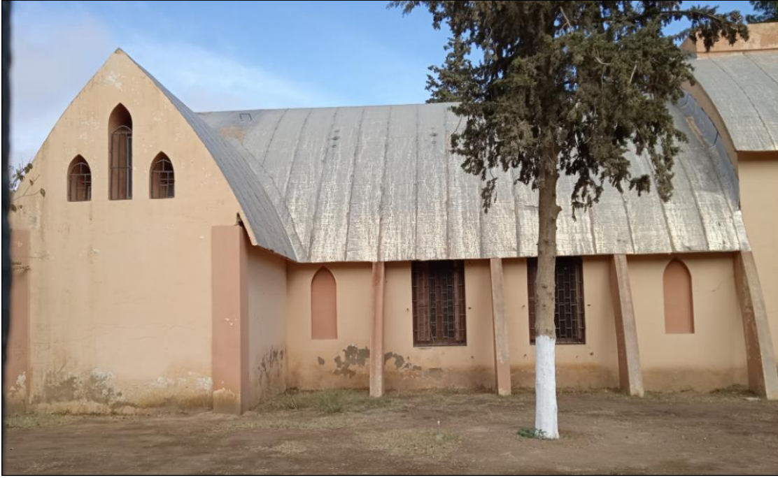
الشكل 97: الواجهة الجنوبية حاليا المصدر: http://ar.wikipedia.org
