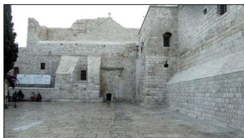
الشكل 44: الواجهة الغربية بعد الترميم المصدر: https://ar.wikipedia.org
