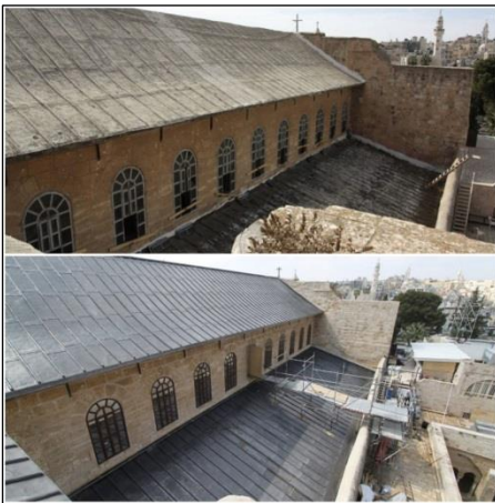
الشكل 38: السقف قبل وبعد الترميم المصدر: https://ar.wikipedia.org
