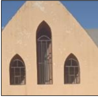
الشكل 43-44-45: حواجز مشبكة للمختلف النوافذ من الفولاذ . المصدر: الطالبة
