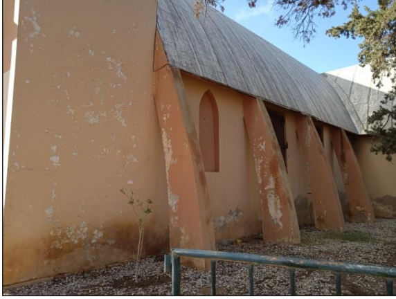
الشكل 94: الأعمدة الحاملة للسقف الحالية المصدر: الطالبة
