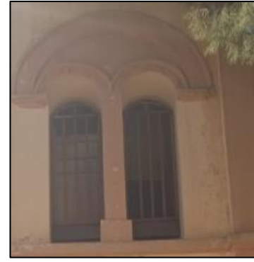
الشكل 43-44-45: حواجز مشبكة للمختلف النوافذ من الفولاذ . المصدر: الطالبة
