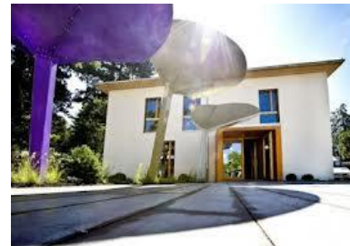
Figure I.16: façades principale de l'exemple 2, MAGAZINE DE CHANTIER
