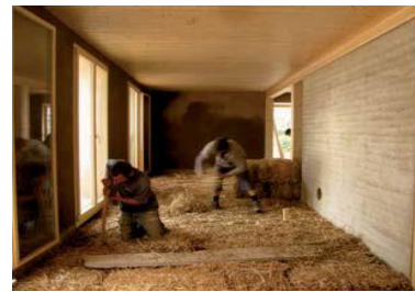
Figure 1.22: vue intérieur sur l'exemple 2, MAGAZINE DE CHANTIER
