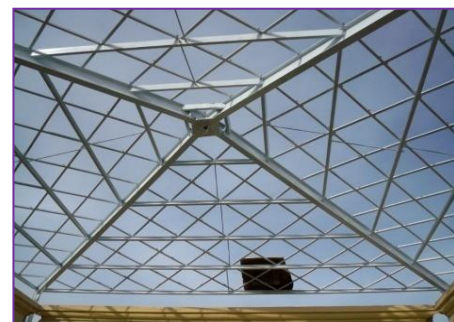
Fig1.63 : La Verrière source : archive DT LAGHOUAT
