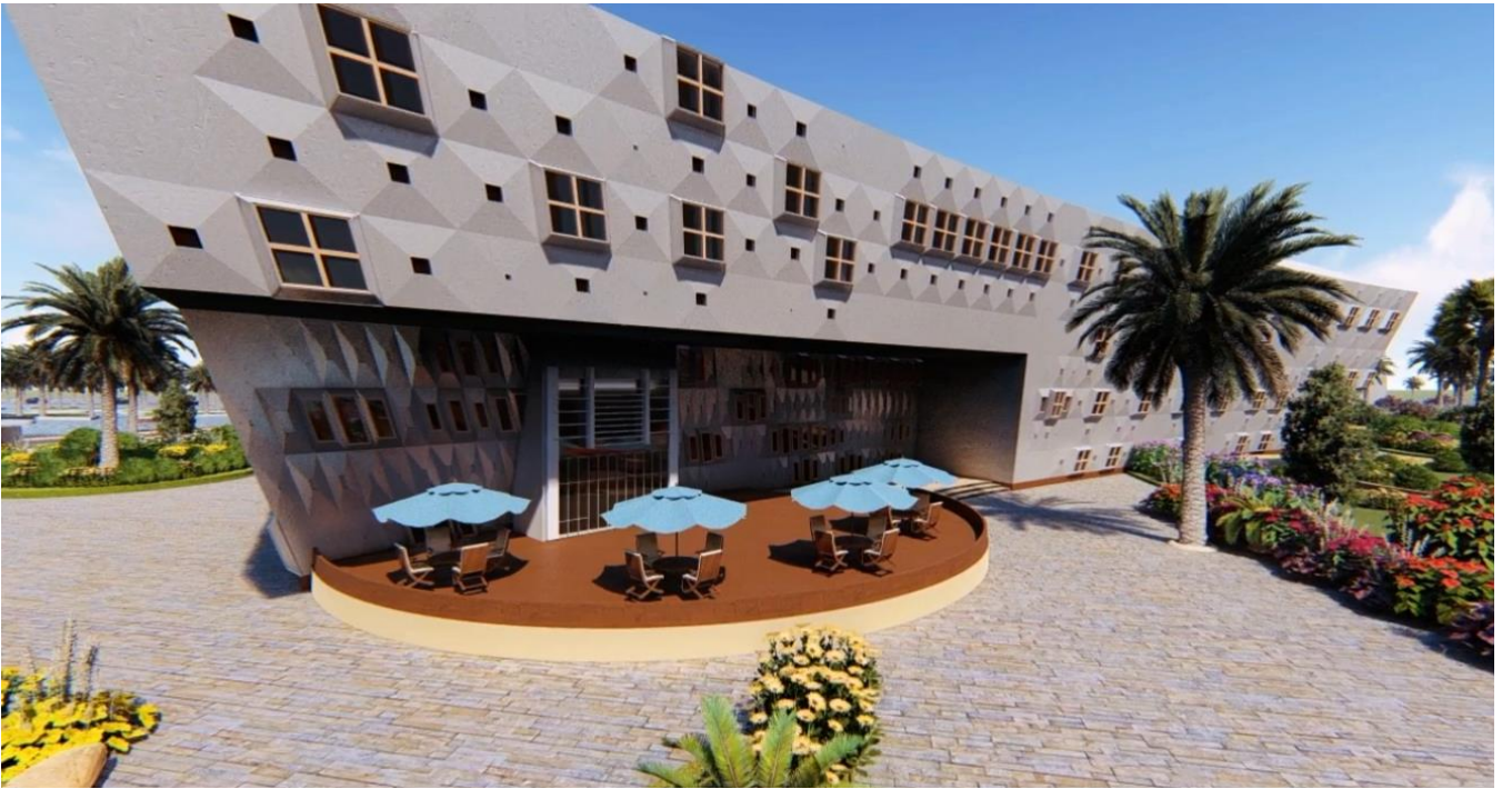
صورة الواجهة الشرقية
