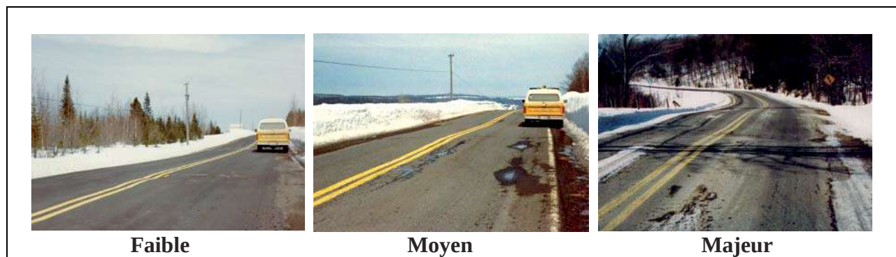
Figure I.11 : soulèvement différentiel (d'après AIMQ 2002)
