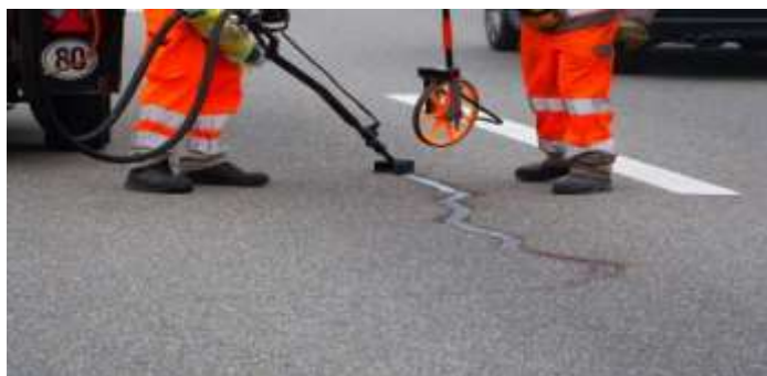
Figure II.11 : PONTAGE DE FISSURES [23]
