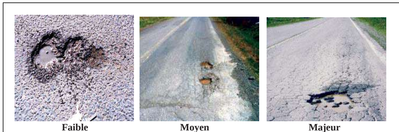
Figure I.30 : Nid de poule (d'après AIMQ 2002)
