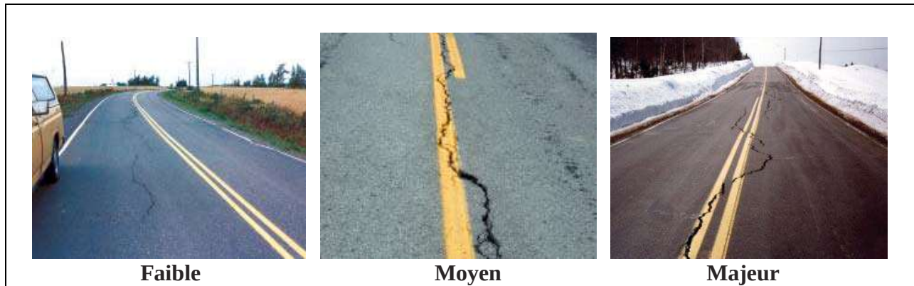
Figure I.21 : Fissures de gel (d'après AIMQ 2002)
