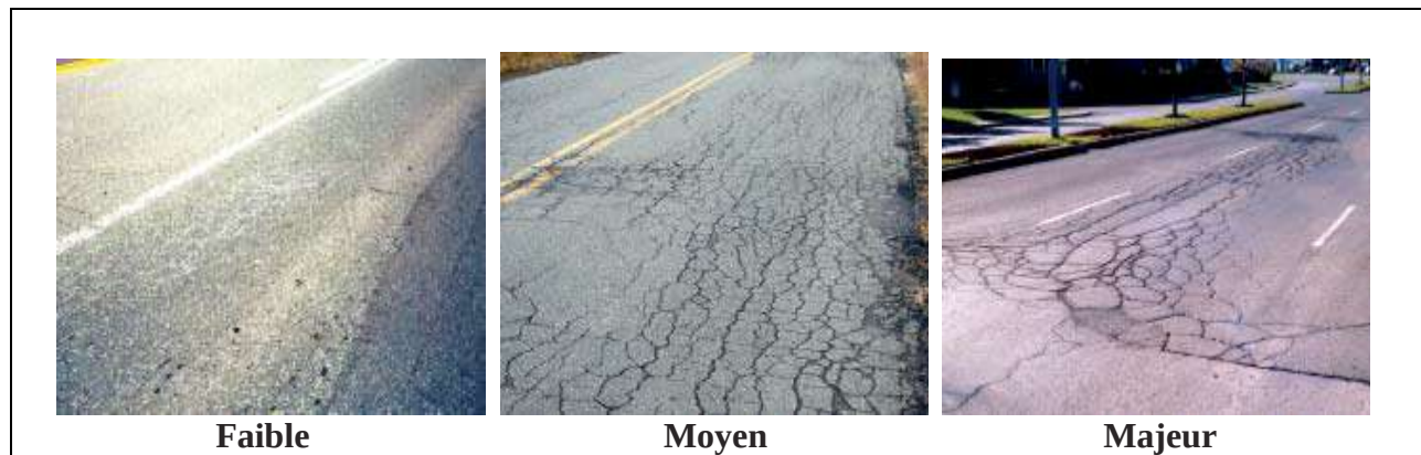
Figure I.22 : Fissures en carrelage (d'après AIMQ 2002)
