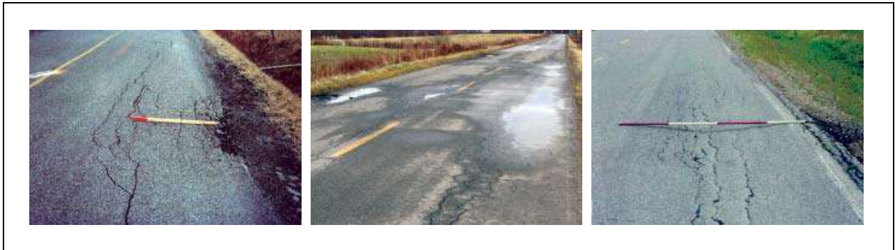
Figure I.9 : affaissements (d'après AIMQ 2002)
