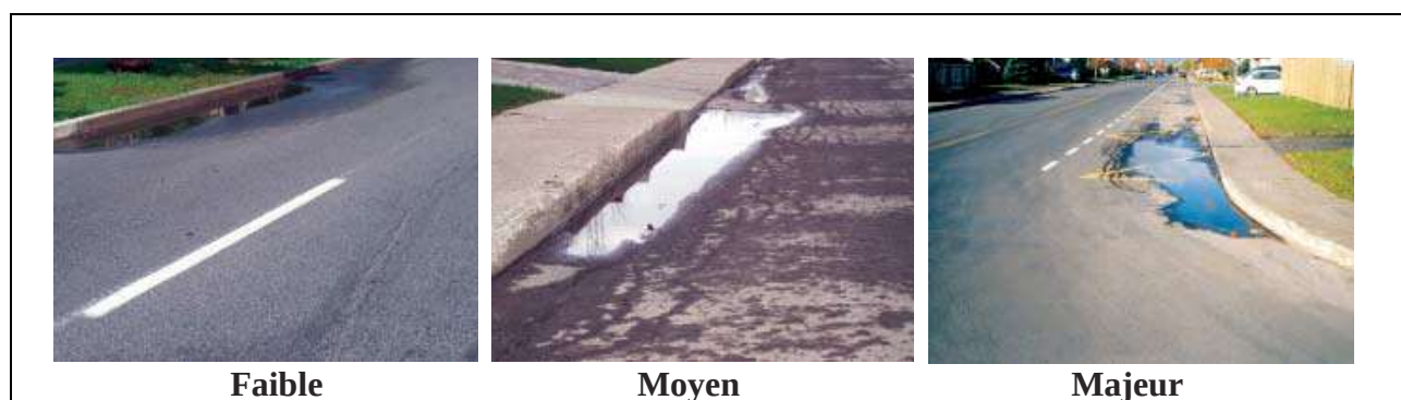
Figure I.13 : Désordre du profil (d'après AIMQ 2002)
