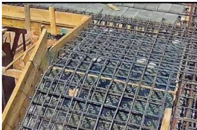
Figure.3.7 : Ferrillage de palie
