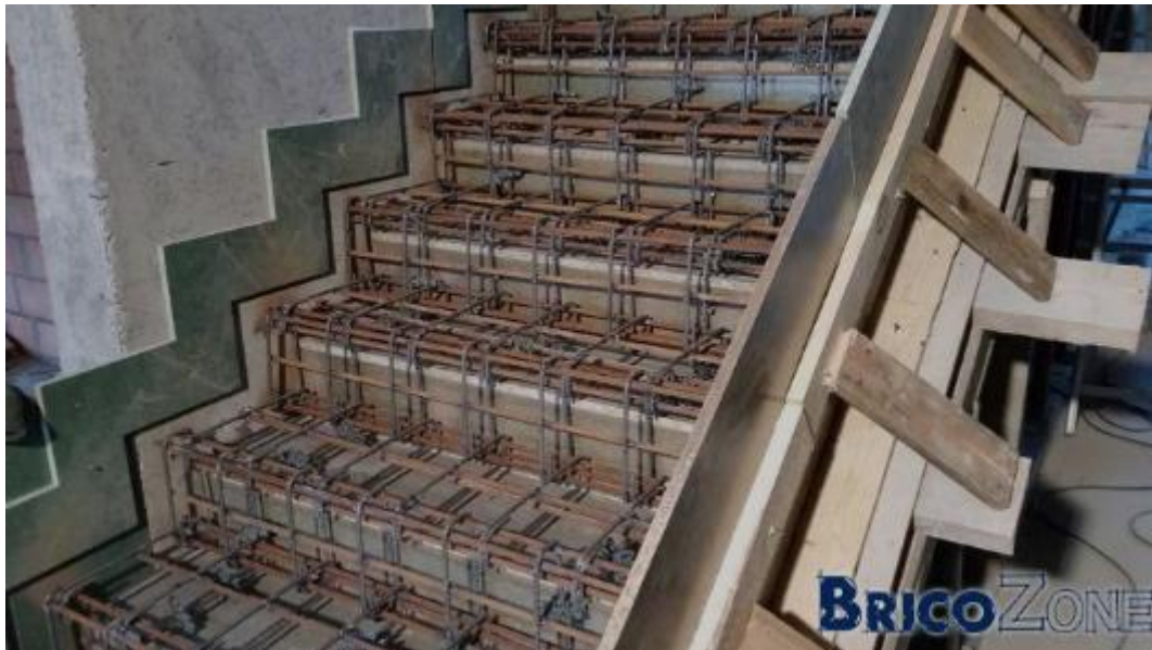
Figure 3.6 : Ferrillage de paillasse
