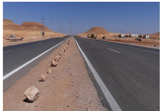
Figure 750 : la RN01 Source : auteur
