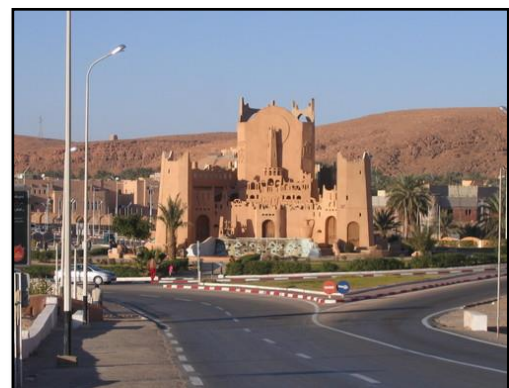
Figure 740 : Carrefour à Sidi Aabaz Source : Google image Source
