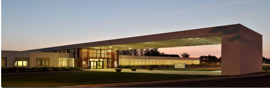
Figure 238 :vue de l'extérieur sur le centre Source : https://www.google.com/search?q=centre+hospitalier+de+pyrenees&biw=
