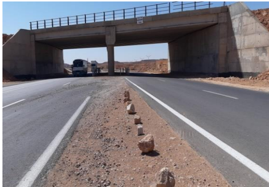
Figure 747 : le pont transformateur Source : auteur
