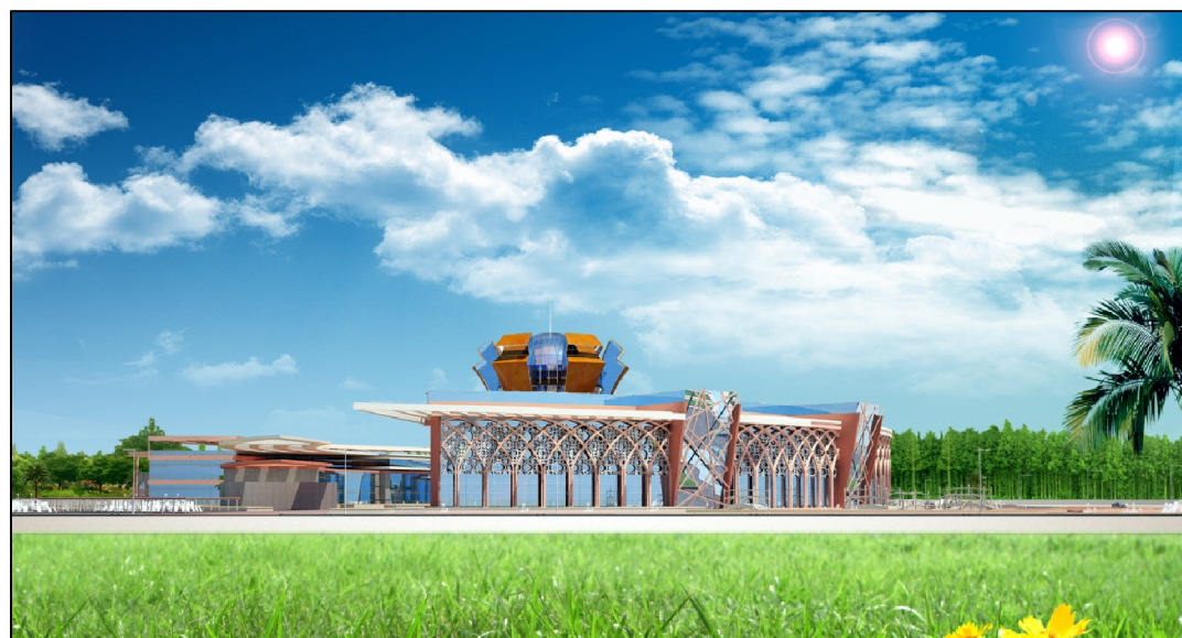
Figure6: vue 3D sur la façade (Sud-ouest)
