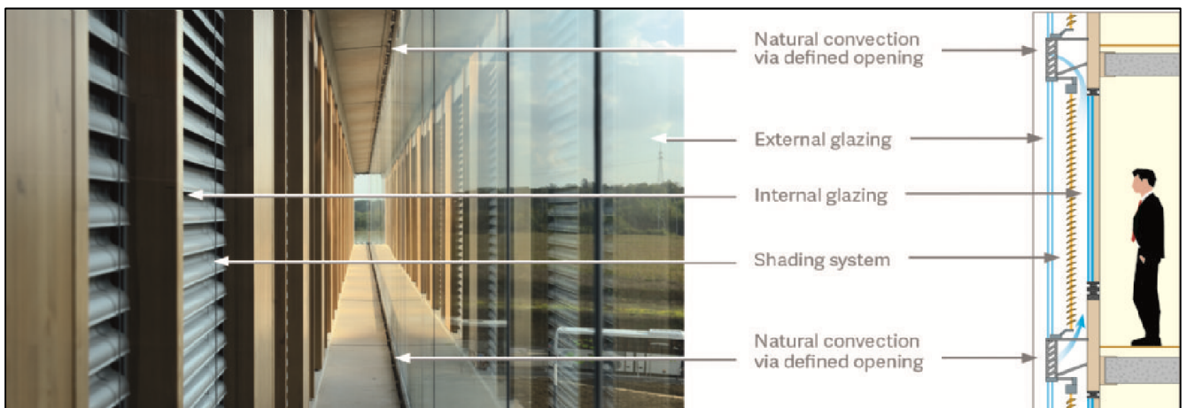
Figure 22: Façade double peaux (système de Ventilation)
