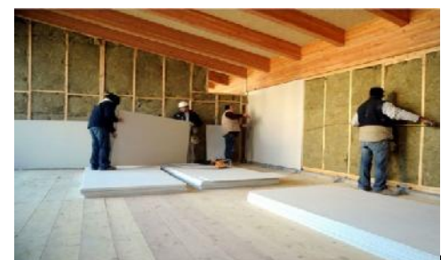
Figure 24: Isolation du bâtiment
