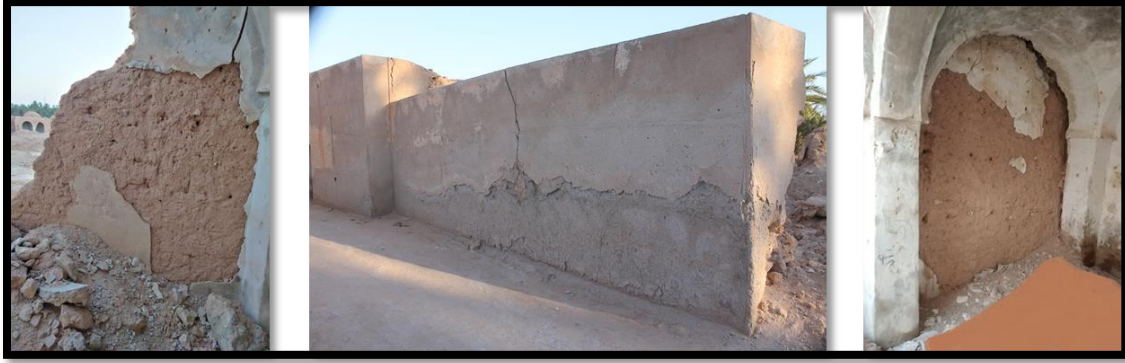
صورة رقم 69: صور لتقشر التليبيسات بقصر تمرنة القديمة
