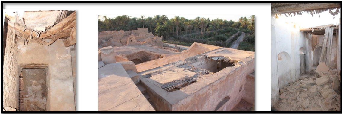
صورة رقم 70 : صور تلف الاسطح و الاسقف بقصر تمرنة القديمة
