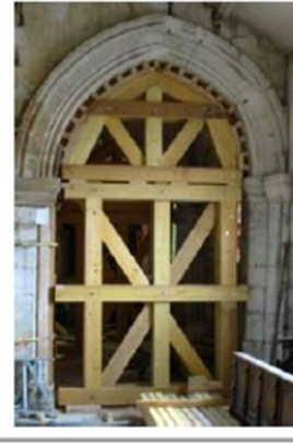
الشكل رقم 39: تقنيات تدعيم الفتحات
