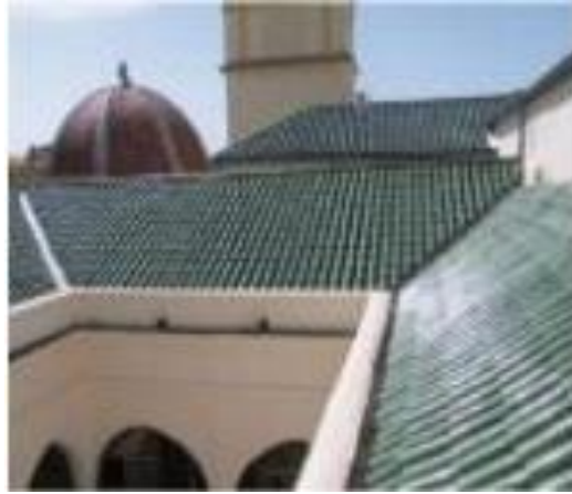
صورة للتغطية الخارجية للأسقف بعد عملية إعادة التأهيل
