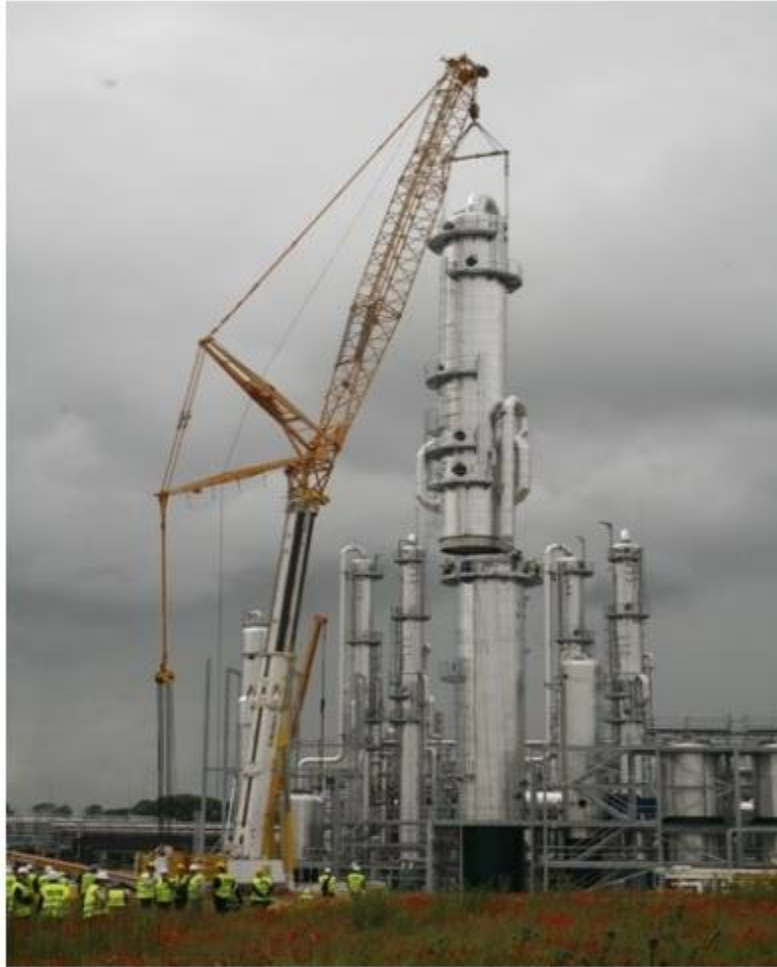
Figure II.1.: Montage d'une colonne de fractionnement.
