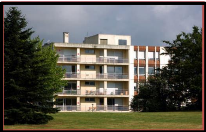
Figure12: façade principale de l'hôpital Antoine Charial (source : www.archimagazine- healthyzone.com )
