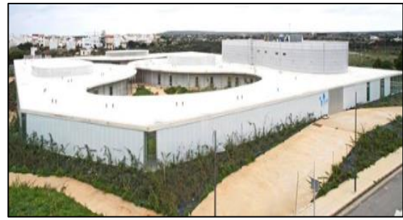
Figure 60: La toiture est complètement plane
