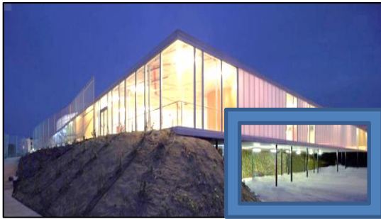
Figure 59: La façade ouest de la volumétrie et sous pilotis variété de conception
