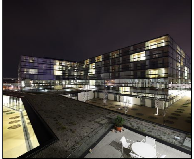
Figure19: hôpital gériatrique donaustadt vienne (source : archdaily.com)
