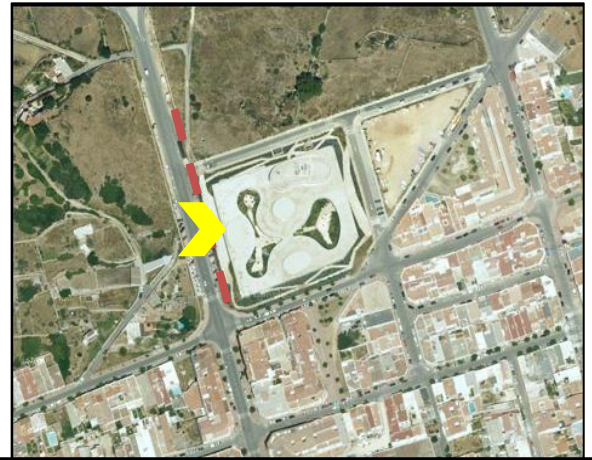
Figure 52 : vue aérienne présente l'entrée mécanique du centre Santa Rita à Barcelone (source : Google map)
