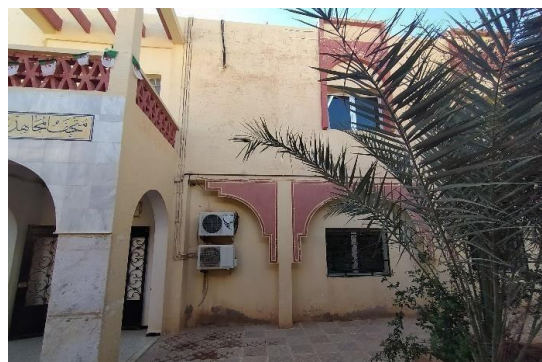
Fig. I. 17: La nouvelle extension. Source : Auteur
