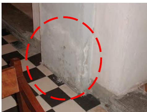
Fig. I. 31: Les sols en carreaux de ciment dégradant les marches et les parements enduits. Source : Restauration de l'église de Figari et de son clocher, Etude de Diagnostic, Janvier 2015 /P.36
