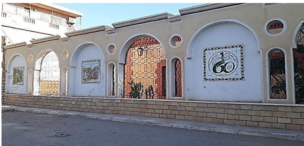
Fig. I. 23: Façade principale de musée de Moudjahid. Source : Auteur
