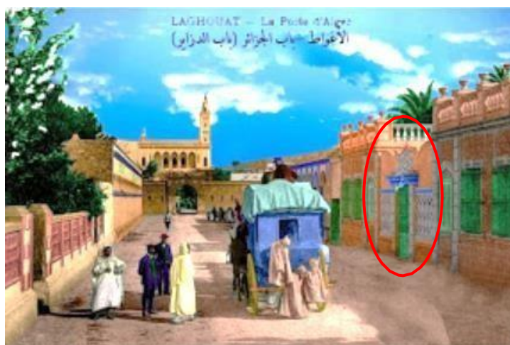
Fig. II. 20 : La synagogue de la ville de Laghouat. Source : Groupe Facebook : Bibliothèque de l'Architecture et de Patrimoine
