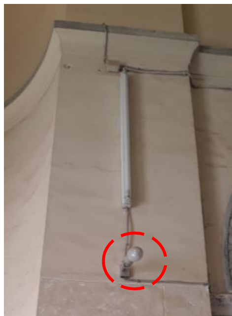
Fig. III.58 : Spot incandescent pour l'éclairage de musée. Source : Auteur
