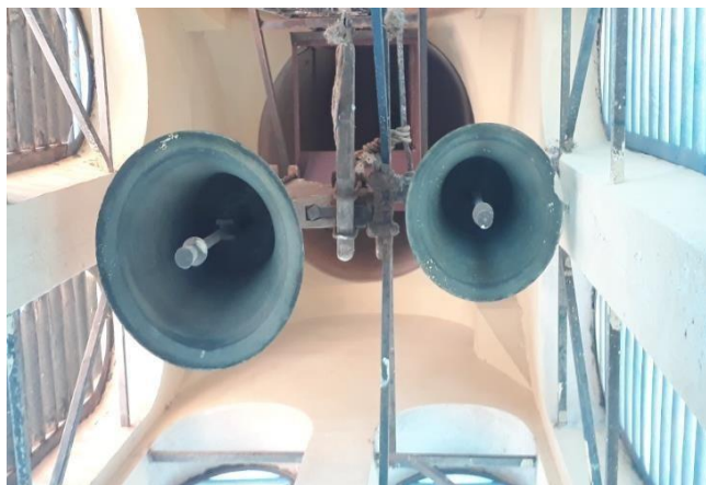
Fig. III.31 : Les cloches de la tour Ouest. Source : Auteur
