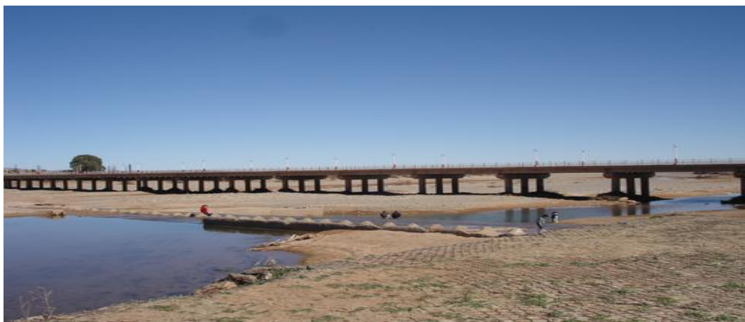
Figure13 : Photos du Barrage de Tadjmout, source : Google Earth
