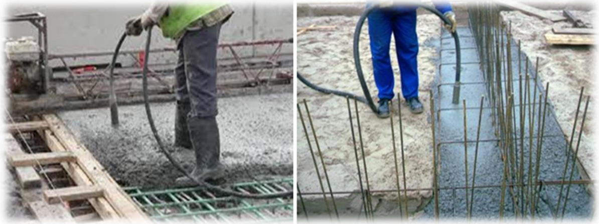
Figure I-2 : Vibration du béton au moment du coulage
