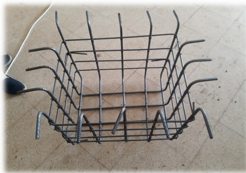
Figure III-15 : Ferrailage de regard renforcé
