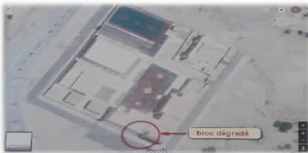
Figure III-2 : Partie dégradée du projet
