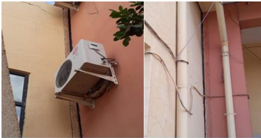
Figure III-21 : Ouverture excessive des joints de dilatation
