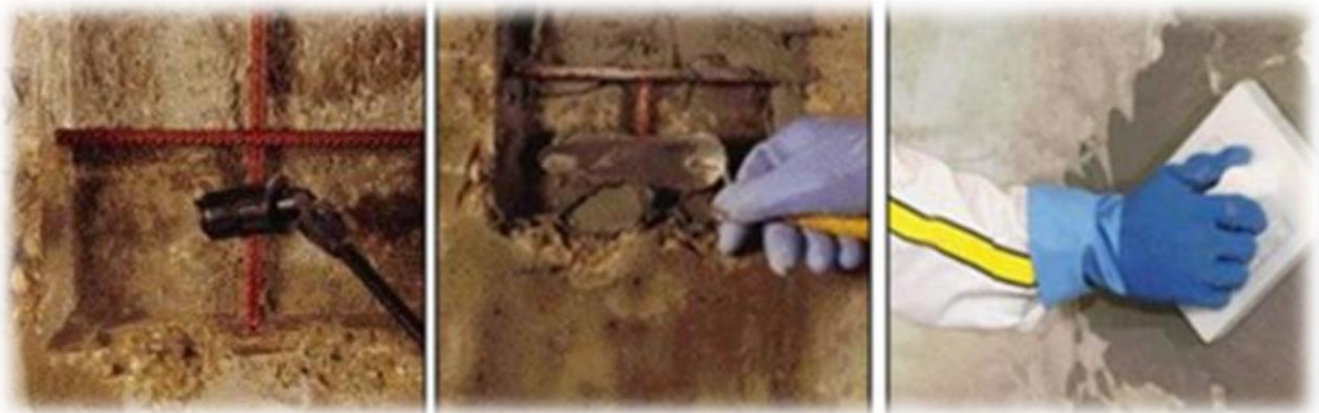
Figure I-20 : Application du mortier et Finissage par taloche.
