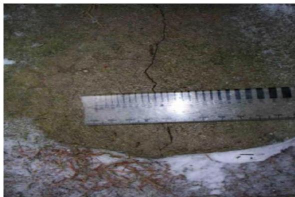
Figure II-2 : Mesure d'une fissure à l'aide d'un fissure-mètre
