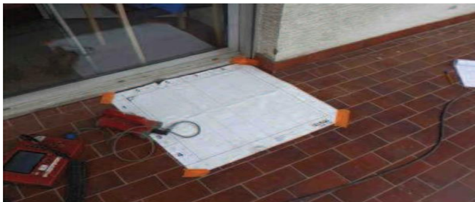
Figure II-6 : Détection des armatures d'un balcon
