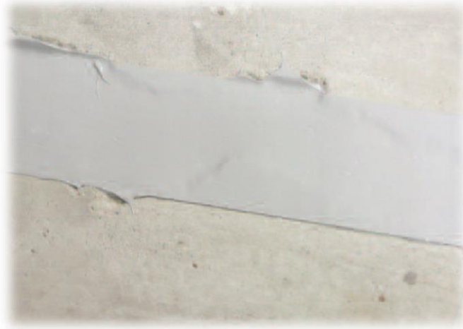
Figure I-24 : Calfeutrement d'une fissure à l'aide d'un mastic
