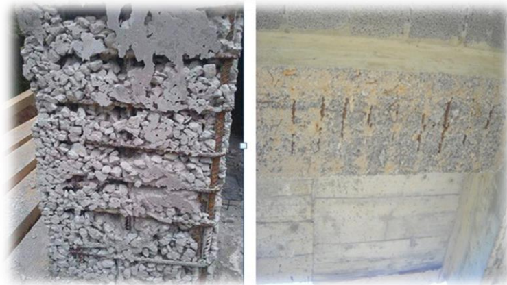
Figure I-1: Ségrégation des éléments en béton armé
