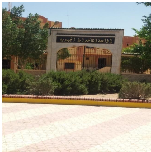
Figure III-17 : Façade principale de la radio
