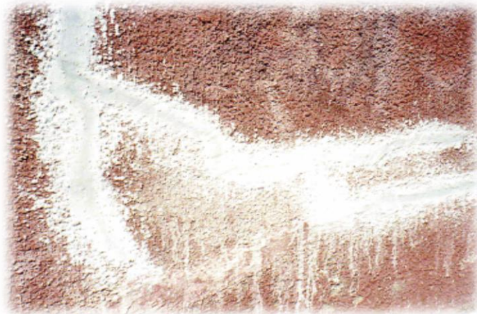
Figure I-23 : Calfeutrement des fissures
