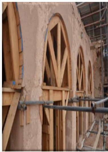
Photo II-18: Les travaux d'urgence sur le balcon de la khaloua (Direction de la culture, ELBAYADH, 2020)
