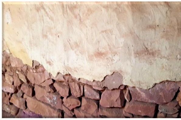
Photo III-19 et III-20 : La pierre utilisée dans la construction des murs
