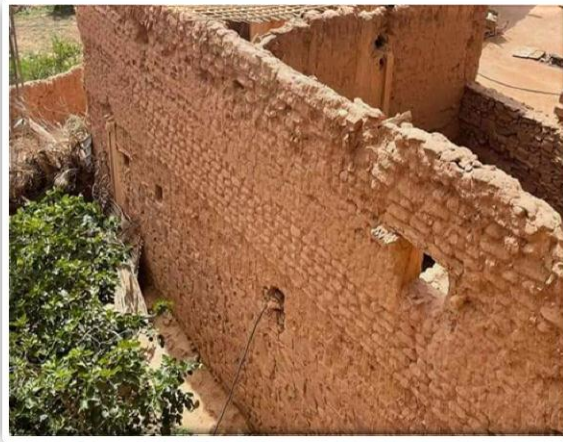
Photo III-26: Murs porteurs du ksar Bousseghoun
