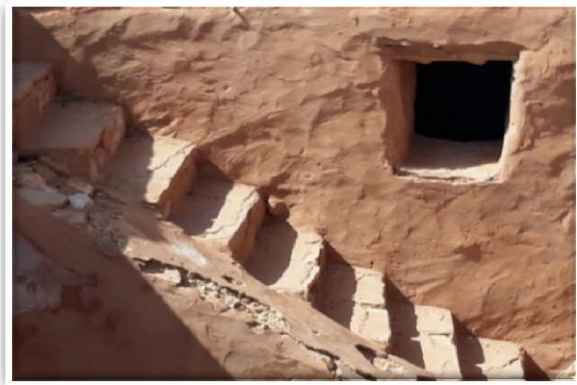
Photo I-9: Escalier d'une maison de ksar (Source : Direction de la culture - El Bayadh)
