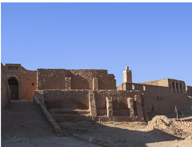
Photo II-8 : Ksar Arbaouat ( Source : Direction de la culture d'El Bayadh -2016 )
