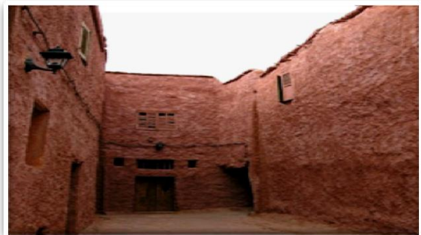
Photo I-5: Façade des maisons de ksar (Source : Ait saadi ,2015)
