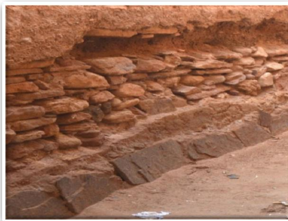
Photo III-25: Mur de soutènement d'une maison
