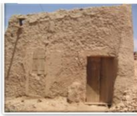
Photo 20: Entrée de la maison du kaid
