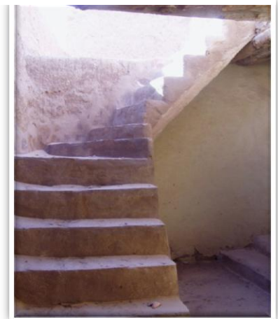
Escalier balancé en L avec deux volets
