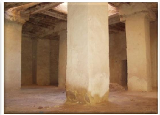
Photo III-9: Riwak d'une maison (Auteur, Ph,P 05/2021)
