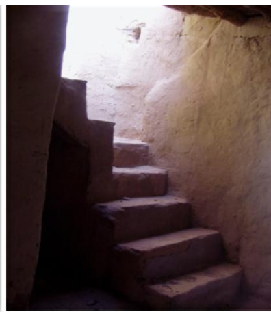
Escalier en L avec deux volets et un palier de repos
