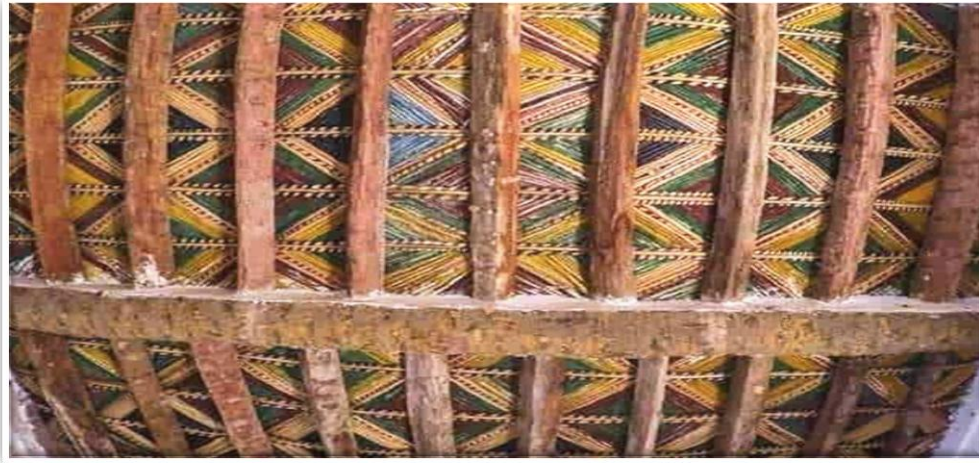
Photo II-17: Eléments décoratifs du plafond de la zaouïa du ksar de Boussemghoun (Auteur, Ph P,04/2021)
