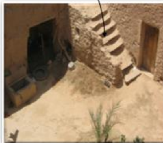
Photo 22: Les escaliers montent sur la terrasse
