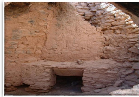
Photo I-10: Type de cheminée de ksar (Source : Direction de la culture - El Bayadh)
