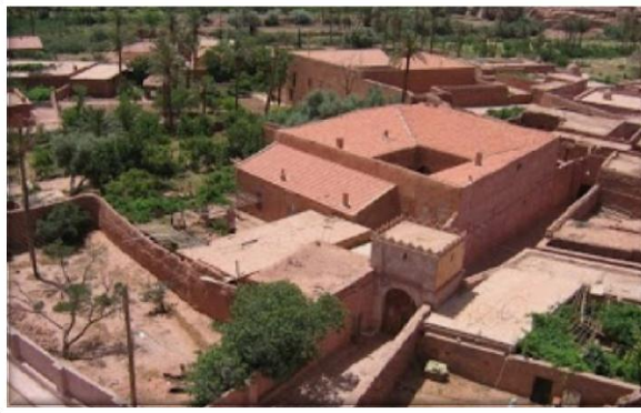
Photo I-2 : Vue d'entrée de ksar Tiout (Source : Ait saadi ,2015)
