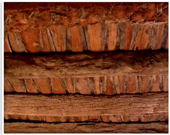
Photo III-23 et III-24: La crosse de palmier utilisée dans le plancher des maisons
