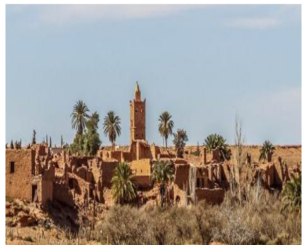
Photo II-9 : Ksar Chellala ( Source : AN.D.T-2016 )
