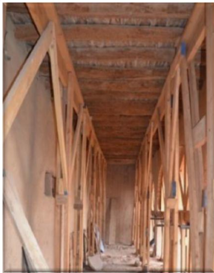
Photo II-18: Les travaux d'urgence sur le balcon de la khaloua (Direction de la culture, ELBAYADH, 2020)
