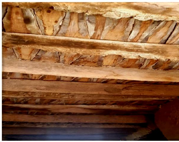
Photo III-23 et III-24: La crosse de palmier utilisée dans le plancher des maisons
