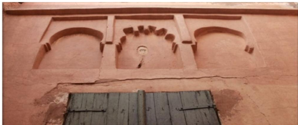
Photo II-15: Détail Architectonique situé sur le Minaret de la mosquée du ksar de Boussemmghoun (Auteur, Ph P, 04/2021)
