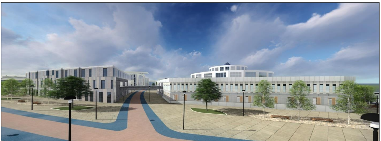
Figure 239 : vue sur le centre de formation, source fait par les auteurs
