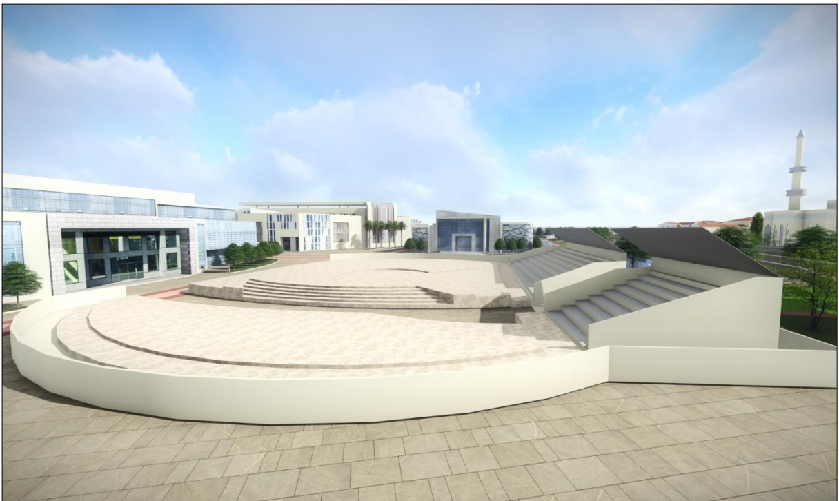
Figure 216 : vue sur l'espace d'exposition, source : fait par les auteures
