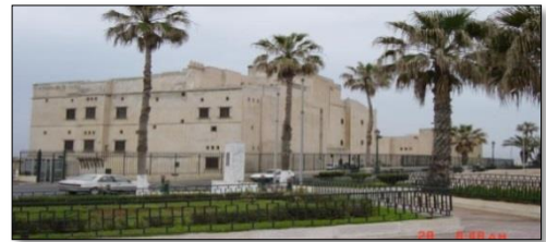
Figure 5 : Exemples restauration, source : rapport technique (opération de sauvegarde et restauration du bastion 23/Alger)
