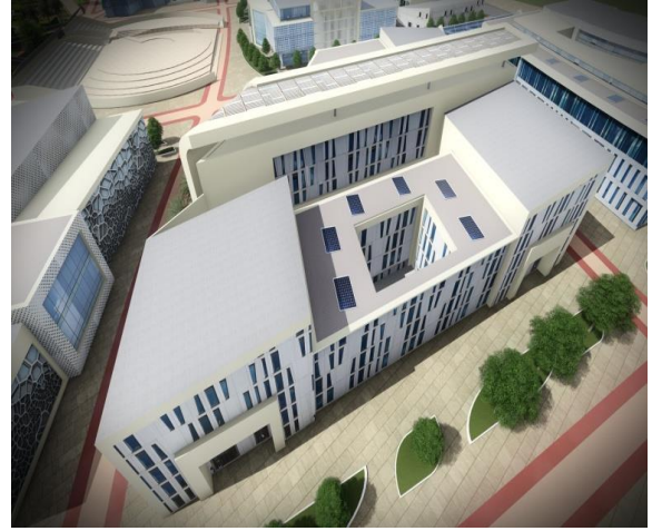
Figure 229 : vue sur l'hôtel, source : fait par les auteurs
