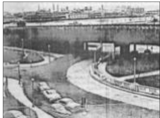
Figure 102 : le carrefour giratoire de Charles Streets, source : livre l'image de la cité
