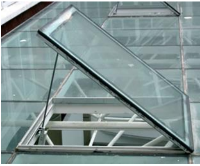
Figure 46:des verrières ouvertures
