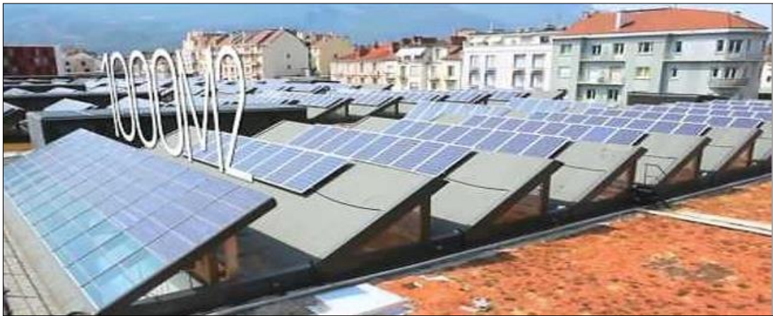
Figure 42: les panneaux photovoltaïques, source PDF de bonne de Grenoble
