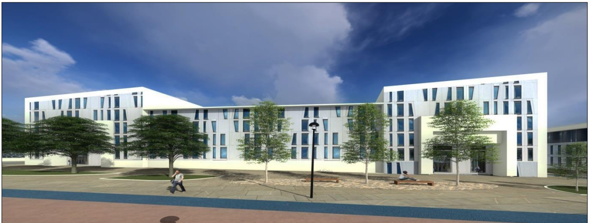
Figure 230 : vue sur l'hôtel, source : fait par les auteurs
