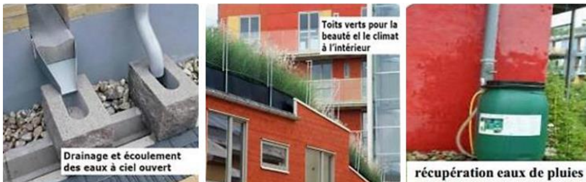
Figure 48: traitement d'eau dans le quartier, source PDF de l'éco quartier de malmo
