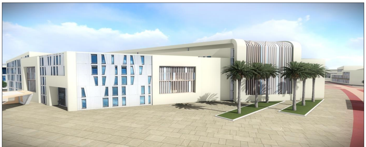
Figure 231 : vue sur l'hôtel, source : fait par les auteurs
