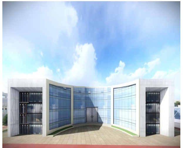
Figure 233 : vue sur le bâtiment bureautique, fait par les auteurs
