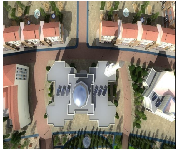
Figure262 :vue sur la mosquée , source fait par les auteures
