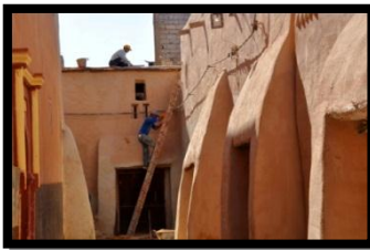
Photo. II.5 L'habillage des façades avec l'enduit de l'argile La source : mholf-bestrating.com
