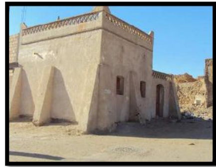
Figure I.10: Ecole coranique réhabilitée ksar Mestaoua
