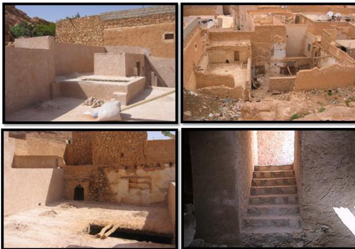
Photo. III.6: Vues de la maison avant de la réhabilitation
