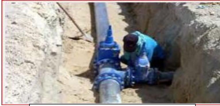
صورة رقم 02: تركيب الصمامات علي شبكة توزيع المياه المصدر: من أرشيف مؤسسة توزيع المياه
