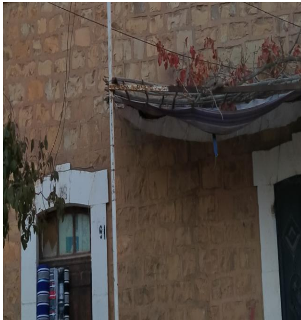
الشكل 175: صورة لجدار خارجي من الحجارة. المصدر: الطالب.
