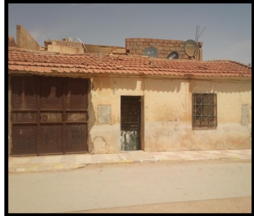
الشكل 72: صورة واجهة المنزل المصدر: مكتب دراسات
