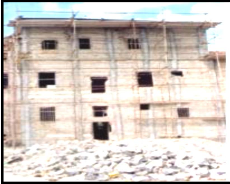
الشكل 103: إعادة تأهيل الواجهة الرئيسية المصدر: google image.
