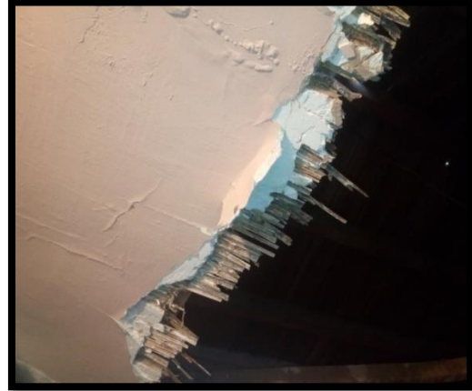
الشكل 74: صورة السقف المهدهد بالسقوط المصدر: مكتب دراسات
