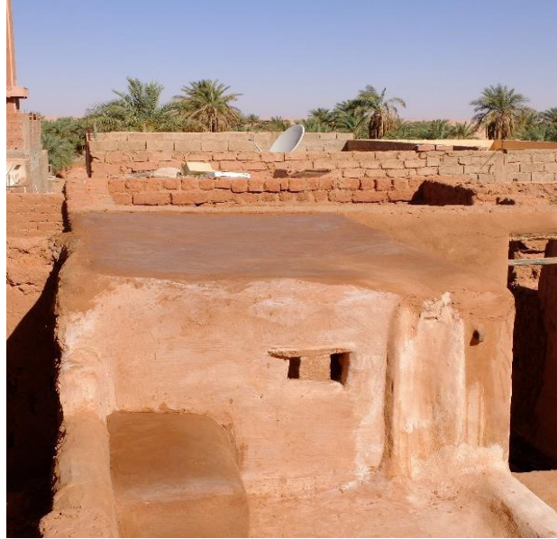
الشكل 120: السقف أثناء عملية التأهيل. المصدر: Guide_rehabilitation_Timimoun.pdf
