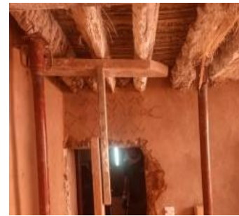
1. تدعيم السقف لتفريغ جزء الجدار الذي يحمله
