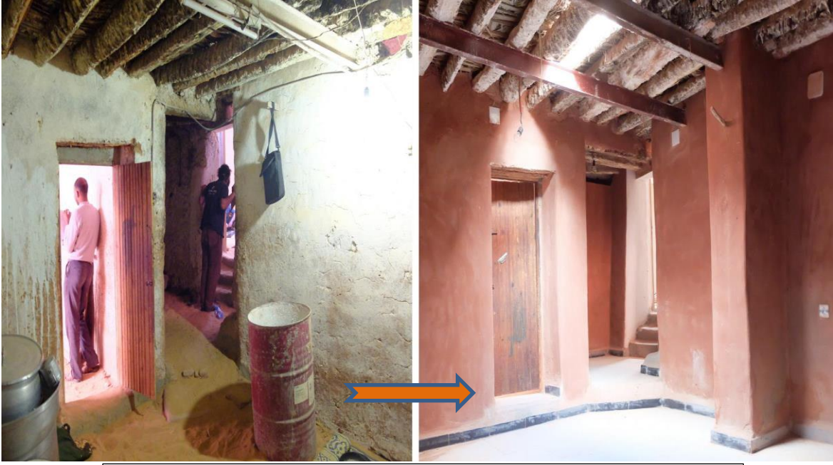
الشكل 125: السقف قبل و بعد التأهيل.
