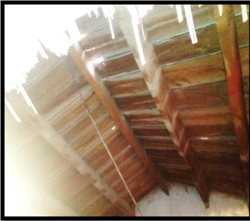
الشكل 73: صورة السقف المهدهد بالسقوط المصدر: مكتب دراسات
