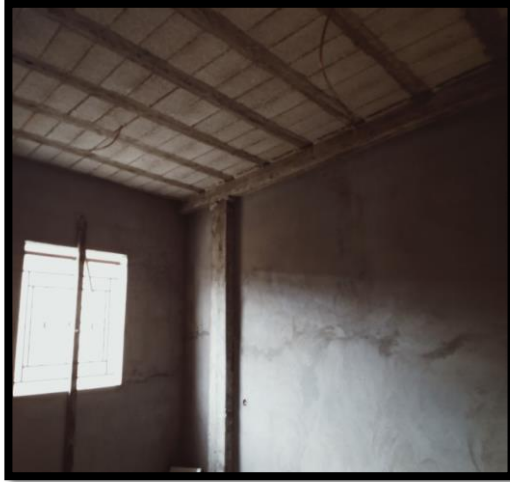
الشكل 85: صورة بعد التأهيل للسقف المصدر: مكتب دراسات
