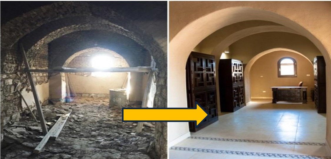
الشكل 95: مقارنة قبل وبعد التأهيل لاستراحة استوبلير المصدر: https://www.walycenter.org/ar/heritage-13/10-heritage/heritage-planning/299-stopplaers-house-rehabilitation-a-reuse
