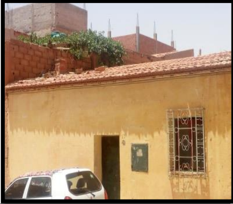
الشكل 63: صورة منزل مراد إعادة تأهيله المصدر: مكتب دراسات
