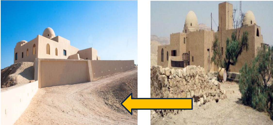
الشكل 94: مقارنة قبل وبعد التأهيل لاستراحة استوبلير المصدر: https://www.walycenter.org/ar/heritage-13/10-heritage/heritage-planning/299-stopplaers-house-rehabilitation-a-reuse
