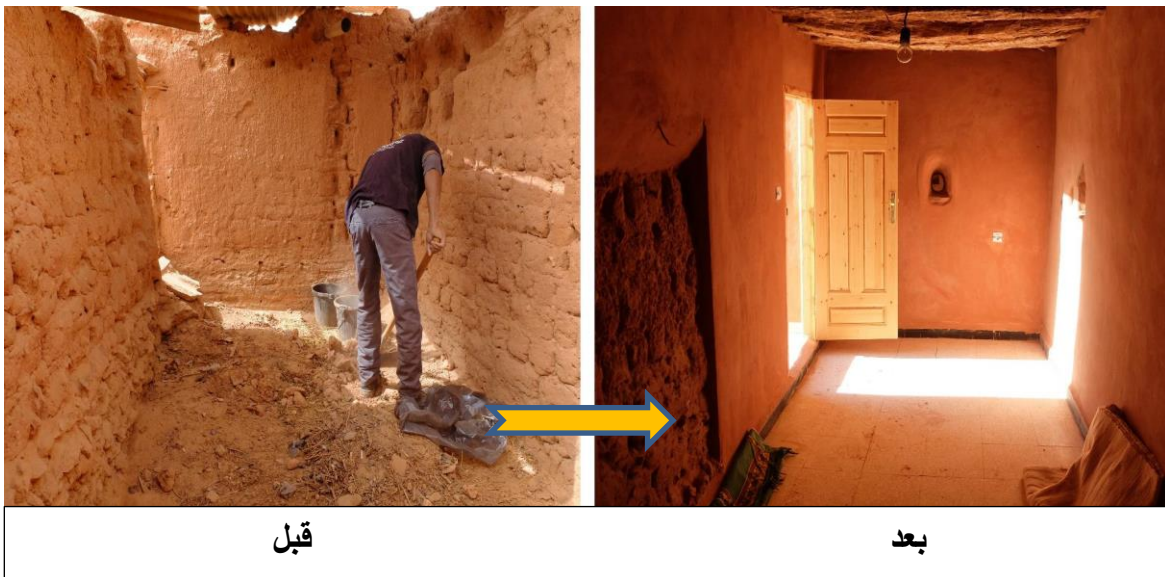
الشكل 134: الجدران الداخلية قبل و بعد التلبيس. المصدر: Guide_rehabilitation_Timimoun.pdf
