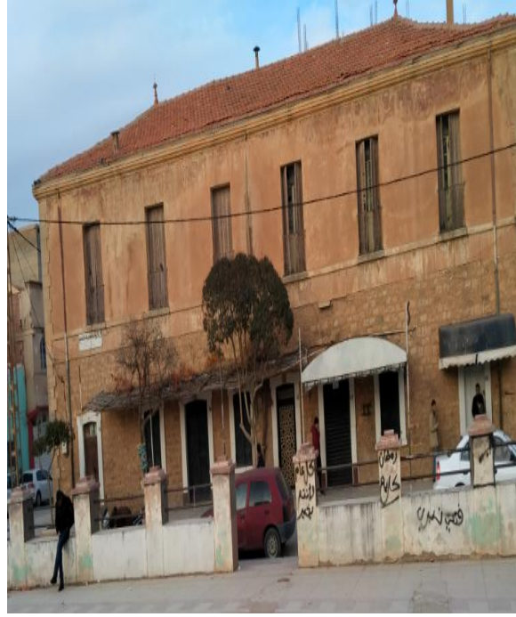
الشكل 161: الواجهة الرئيسية للنزل. المصدر: الطالب.
