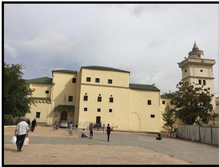
الشكل 101: الواجهة الخارجية لقصر حاج احمد باي قسنطينة المصدر: google image.
