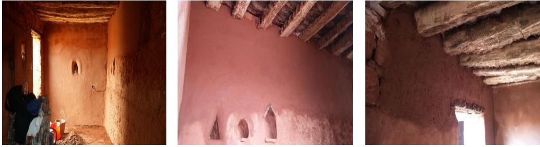
الشكل 133: عملية تلبيس لجران الداخلية بالطين. المصدر: Guide_rehabilitation_Timimoun.pdf
