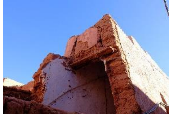
تسرب الترسبات الراكدة تؤدي إلى الإنهيار
