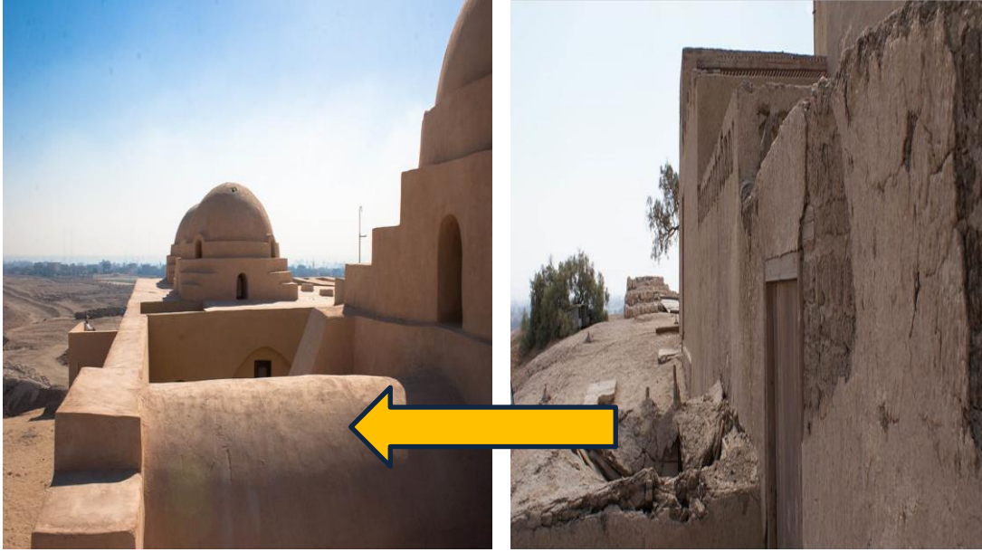
الشكل 96: مقارنة قبل وبعد التأهيل لاستراحة استوبلاير المصدر: https://www.walycenter.org/ar/heritage-13/10-heritage/heritage-planning/299-stopplaers-house-rehabilitation-a-reuse
