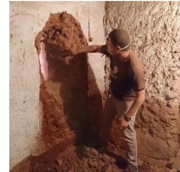
هدم الجزء الداخلي من الاعلى نحو الاسفل
