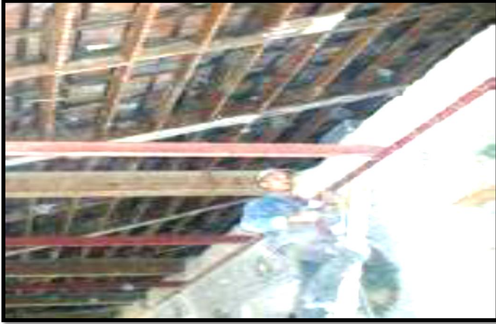
الشكل 107: كمر حديدية تؤمن الحملة على الجدران المصدر: slideplayer.fr .
