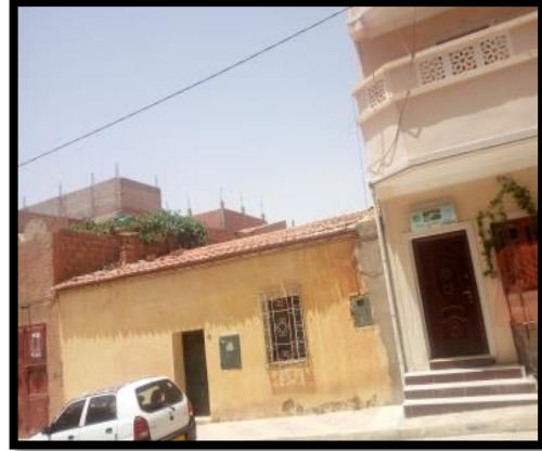
الشكل 62: صورة منزل مراد إعادة تأهيله المصدر: مكتب دراسات
