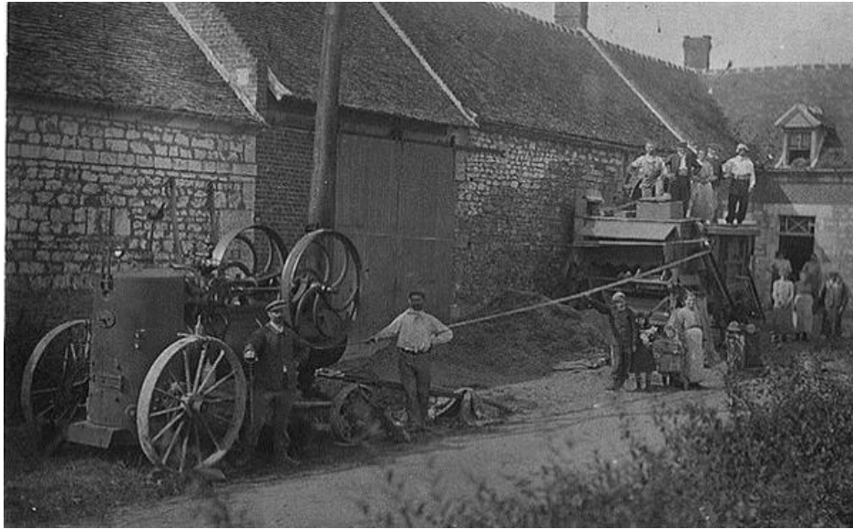
Fig. I.11: La locomobile reliée à la batteuse avec un long courroie
