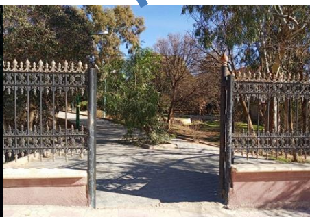
Photo sur porte côté EST
