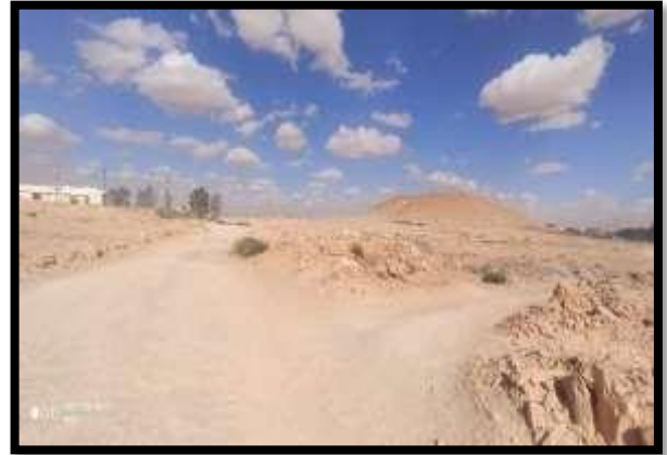
Figure 4 : habitat en cours de réalisation.
