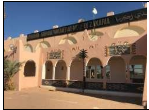
Figure 4 : l'aéroport de Ghardaïa
