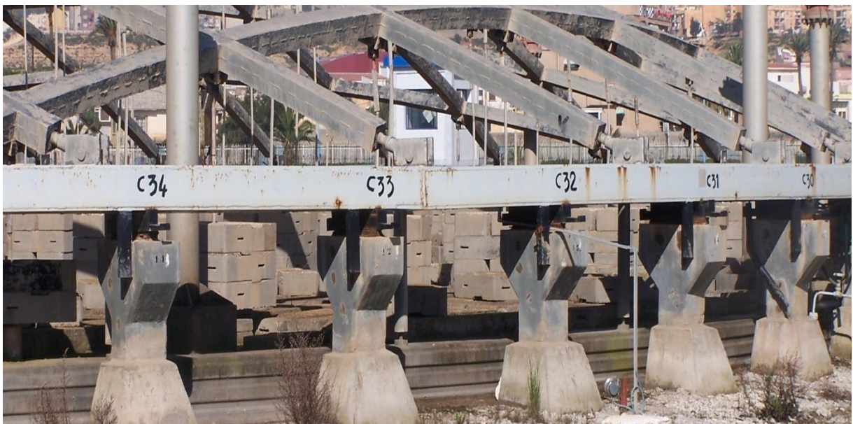
Figure III.18 : Disposition des cibles sur la couronne du bac
