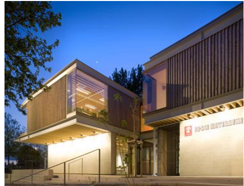
Figure 38: école maternelle Jean Carrière à Nîmes. Source : Tectoniques et Atelier GA Architectes Tectoniques / Dossier de presse - Juin 2012.
