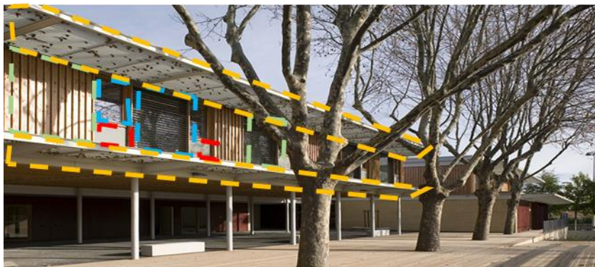
Figure 46: analyse de façade latérale de l'école maternelle «Jean Carrière» à Nîmes. Source : auteur.
