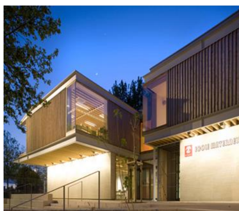
Figure 21: école maternelle Jean Carrière à Nîmes .Source : Tectoniques et Atelier GA Architectes Tectoniques / Dossier de presse -Juin2012.
