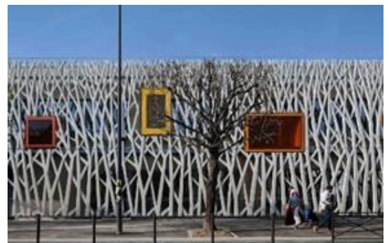
Figure 117 : béton blanc fibré inspiré de la texture végétale .Source : https://www.pinterest.fr
