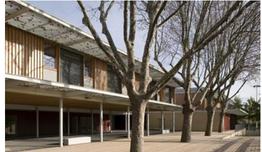
Figure 48 : façade latérale .Source : Tectoniques et Atelier GA Architectes Tectoniques / Dossier de presse -Juin2012.
